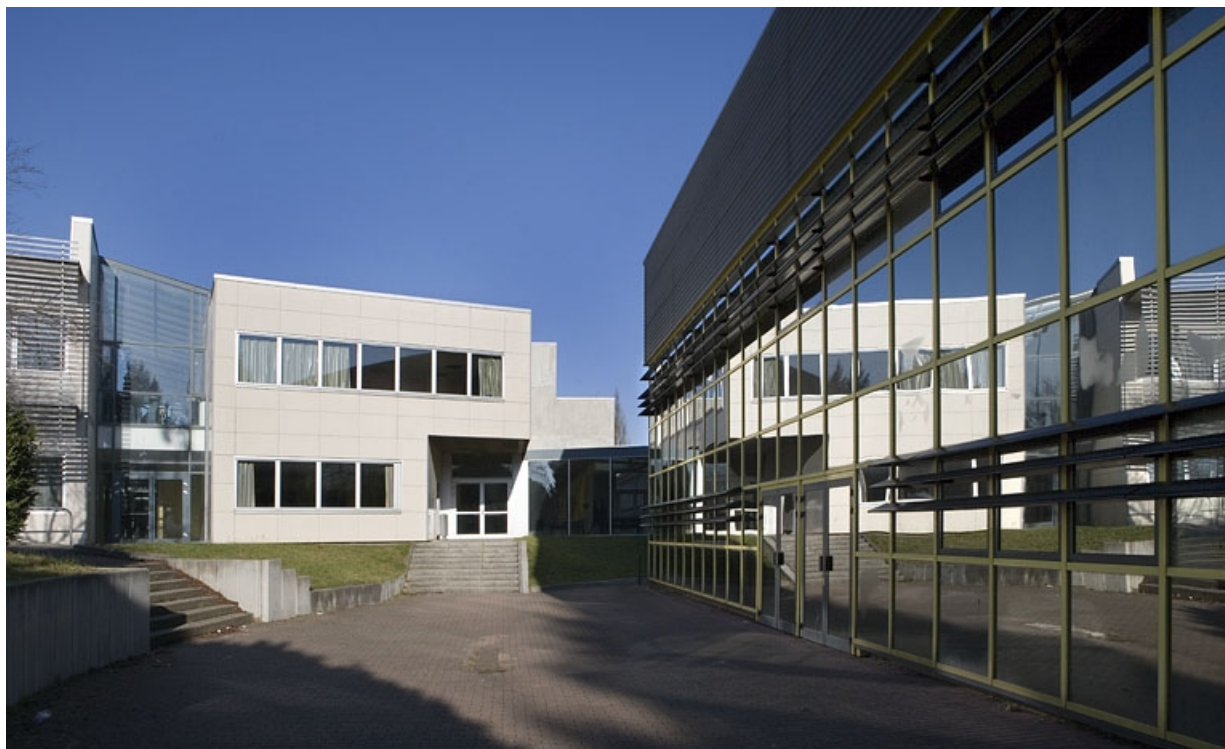
Vue de la façade antérieure bâtiment B.
