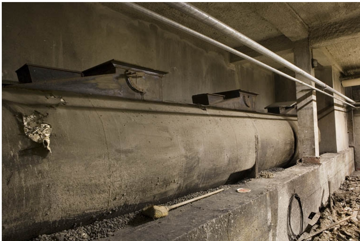
Bâtiment D. Sous-sol. Vue de l'ancienne chaudière à charbon.
