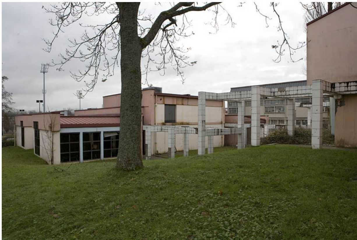
Vue de trois quarts gauche bâtiment J. 25, Montbéliard, 1 B rue Pierre Donzelot
