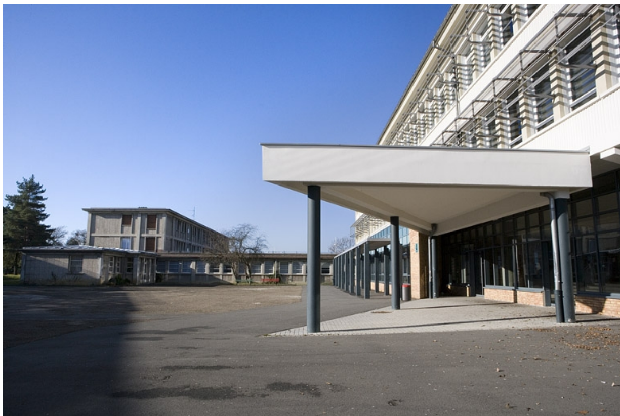
Vue façade antérieure bâtiment A et façade postérieure bâtiment C. 25, Montbéliard, 1 B rue Pierre Donzelot
