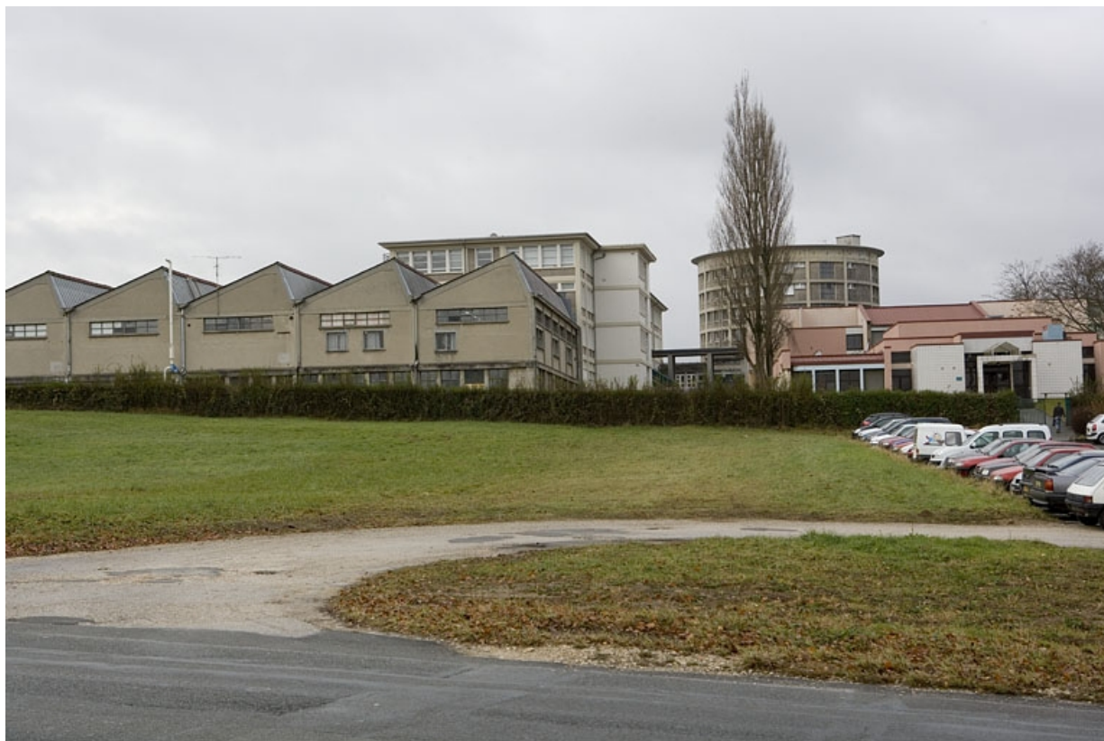
Vue d'ensemble. Façade postérieure du bâtiment B.
