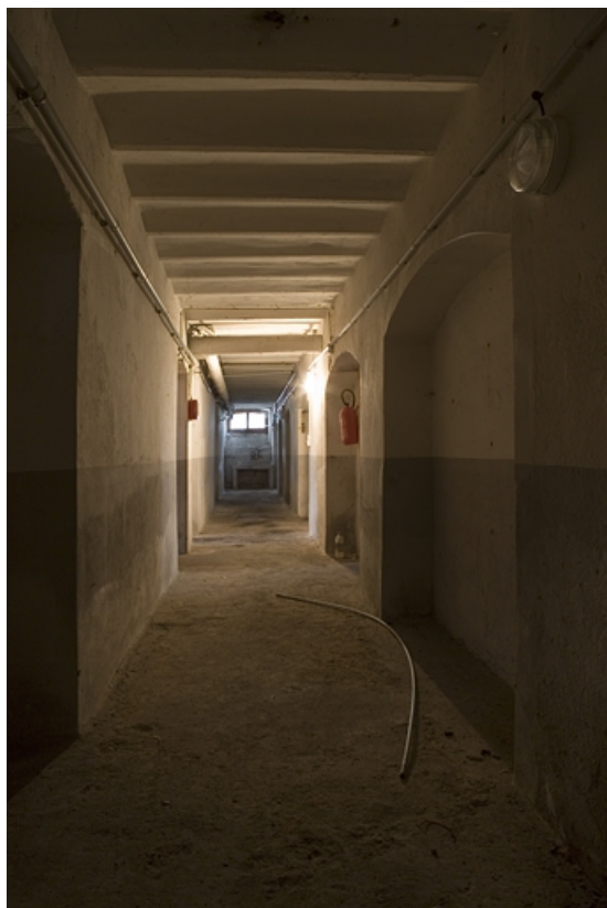
Bâtiment A : sous-sol. Vue du couloir.
