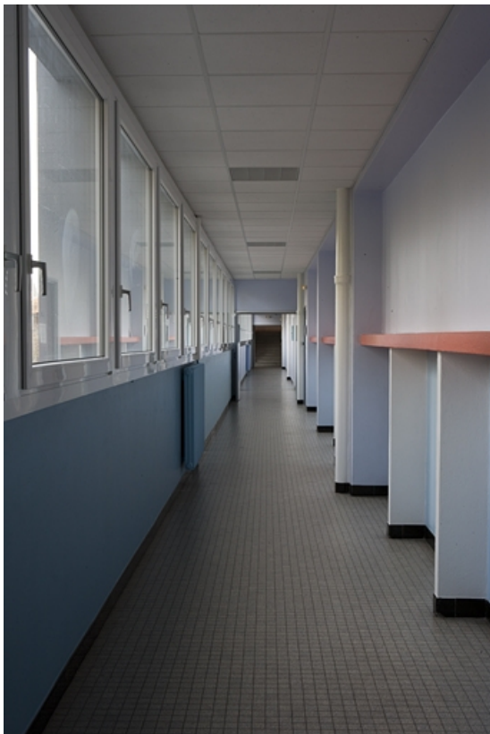
Bâtiment C. Vue couloir.
