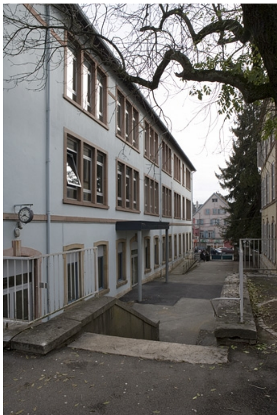
Bâtiment B. Vue face latérale droite.
