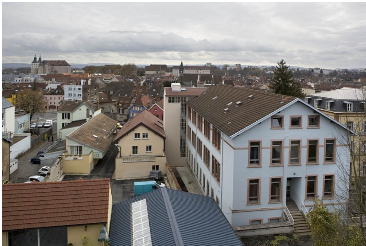
Vue d'ensemble bâtiment B de trois quarts gauche depuis bâtiment C. 25, Montbéliard, 8 avenue de Lattre de Tassigny
