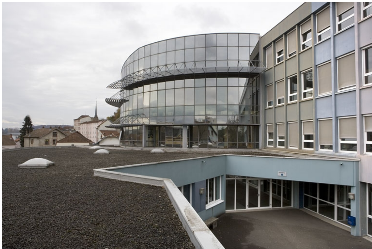
Vue tour bâtiment D depuis le toit.
