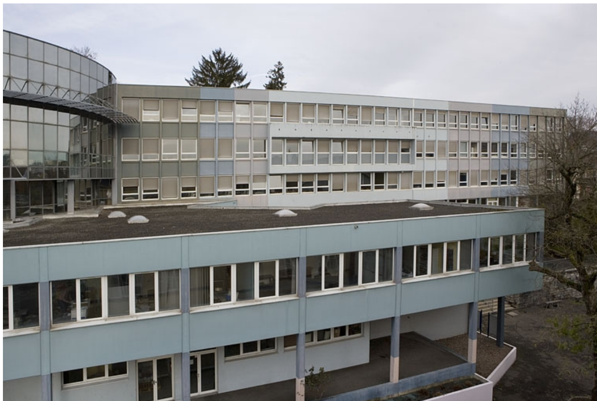
Vue de la façade antérieure du bâtiment C depuis combles bâtiment A.
