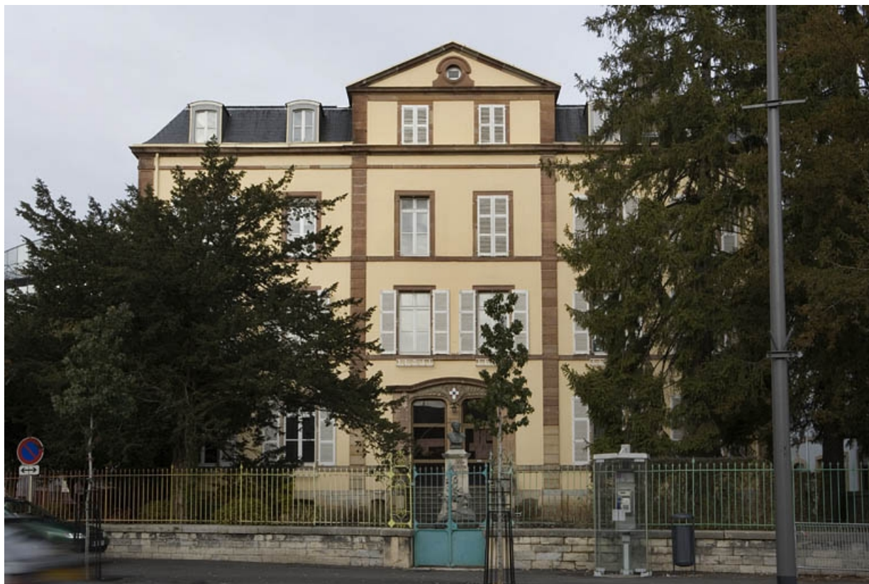
Vue d'ensemble façade antérieure bâtiment A depuis avenue.
