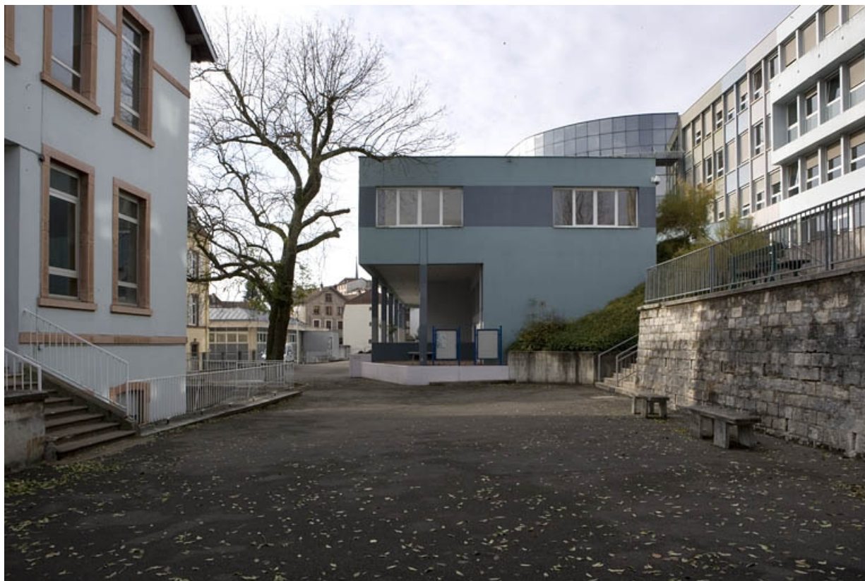
Vue face latérale gauche bâtiment D (partie avant).
