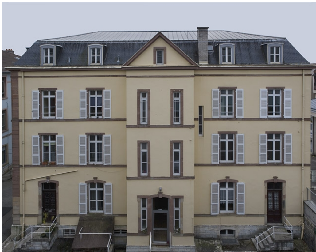
Vue façade postérieure bâtiment A.
