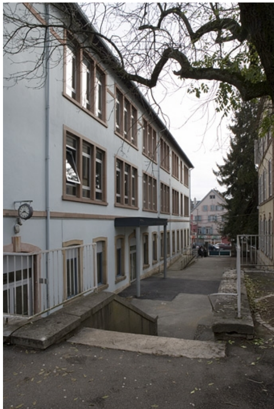
Bâtiment B. Vue face latérale droite.
