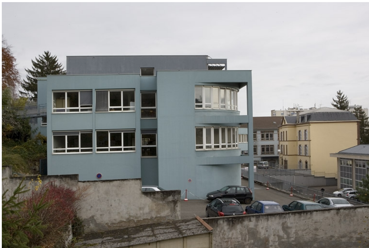
Vue face latérale droite bâtiment D depuis rue. 25, Montbéliard, 8 avenue de Lattre de Tassigny
