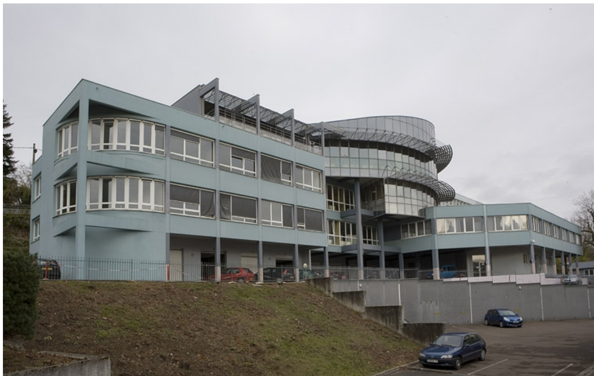
Vue d'ensemble bâtiment D depuis parking. 25, Montbéliard, 8 avenue de Lattre de Tassigny
