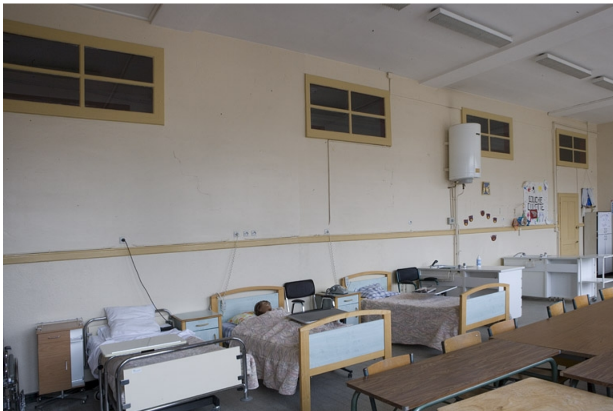
Bâtiment B. Vue salle travaux pratiques services aux personnes et détail hauts-jours intérieurs.
