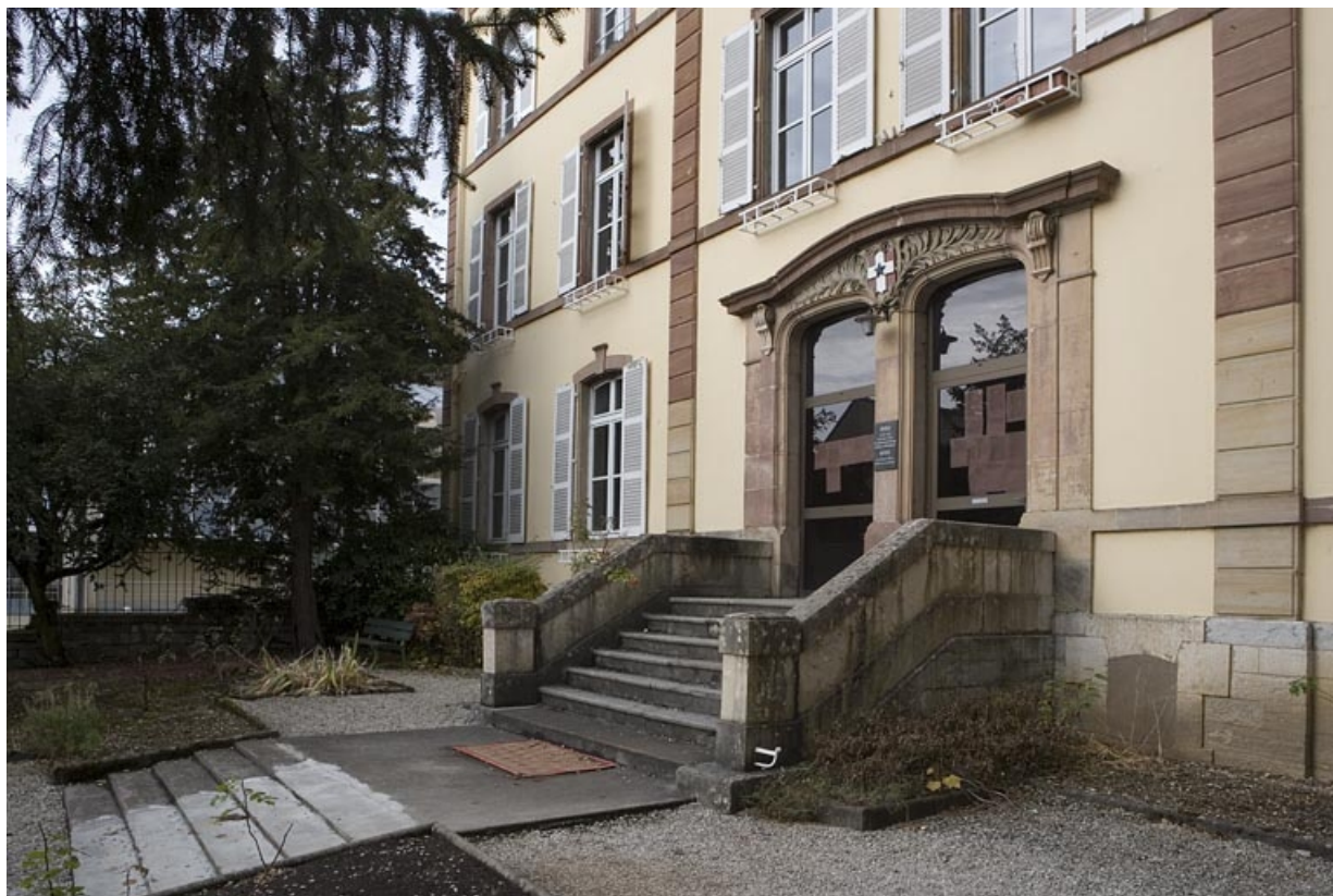
Vue latérale façade antérieure bâtiment A. Perron et porte d'entrée.
