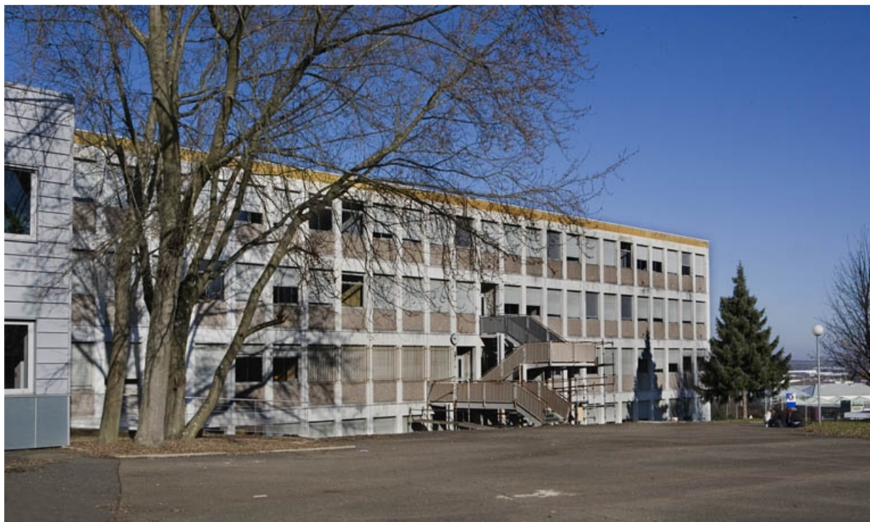
Bâtiment C. Vue de la façade antérieure.
