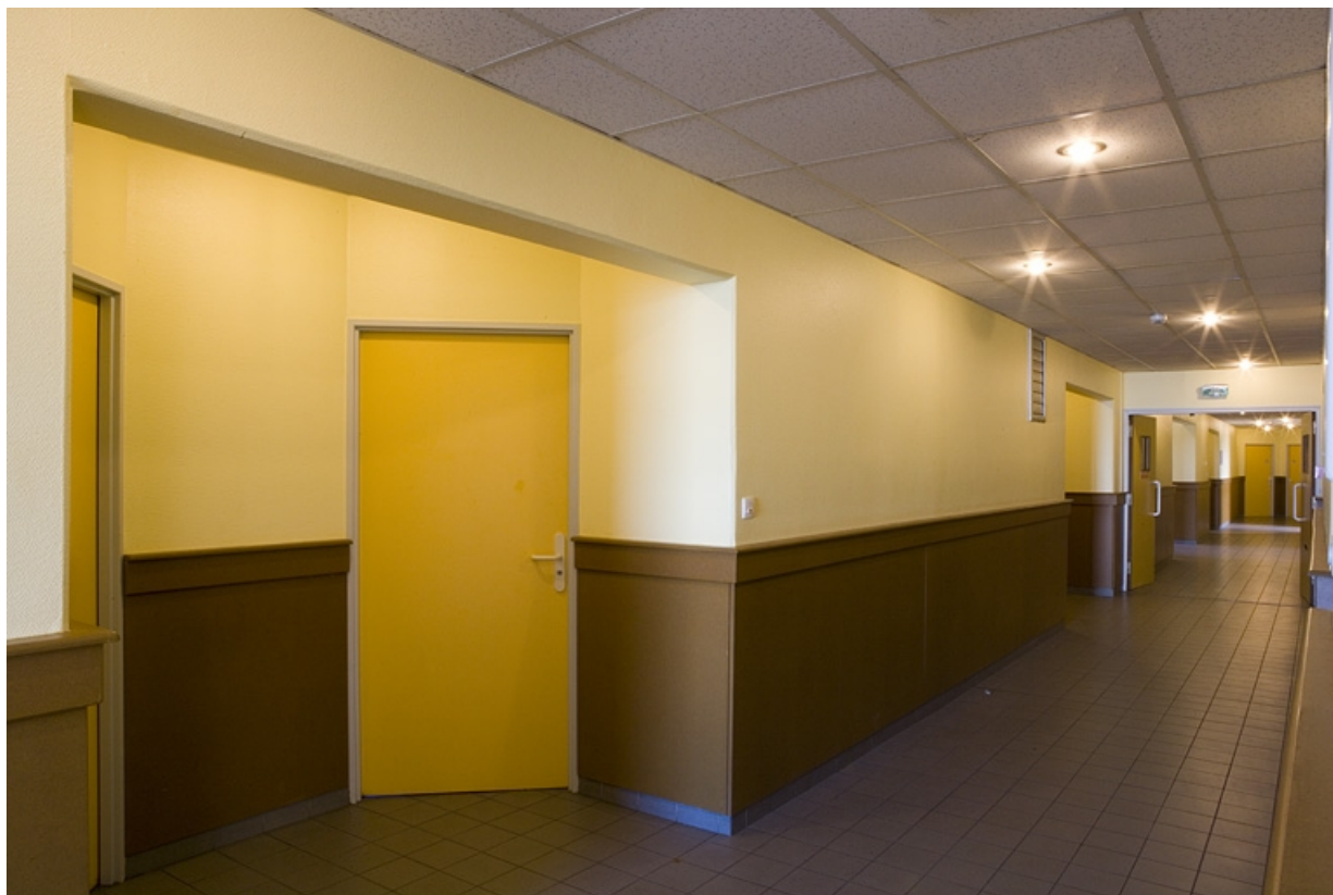
Bâtiment B. Vue du couloir.
