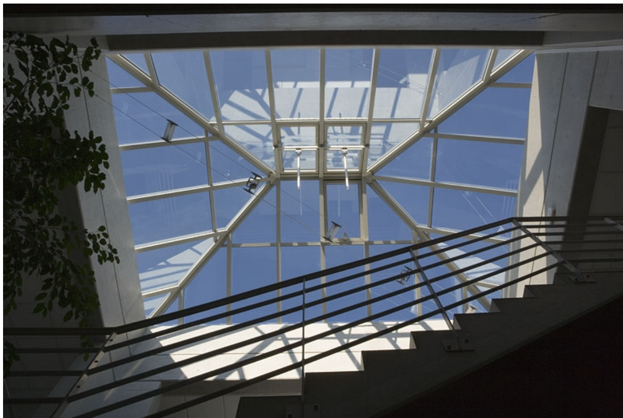
Bâtiment A. Détail de la verrière. 25, Montbéliard rue Pierre Donzelot
