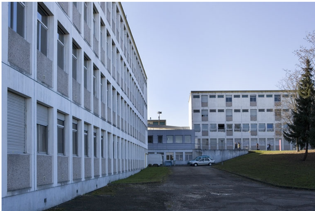
Bâtiment C et D. Vue des façades postérieures. 25, Montbéliard rue Pierre Donzelot
