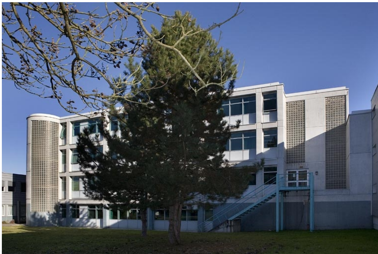
Bâtiment B. Vue de la façade antérieure.
