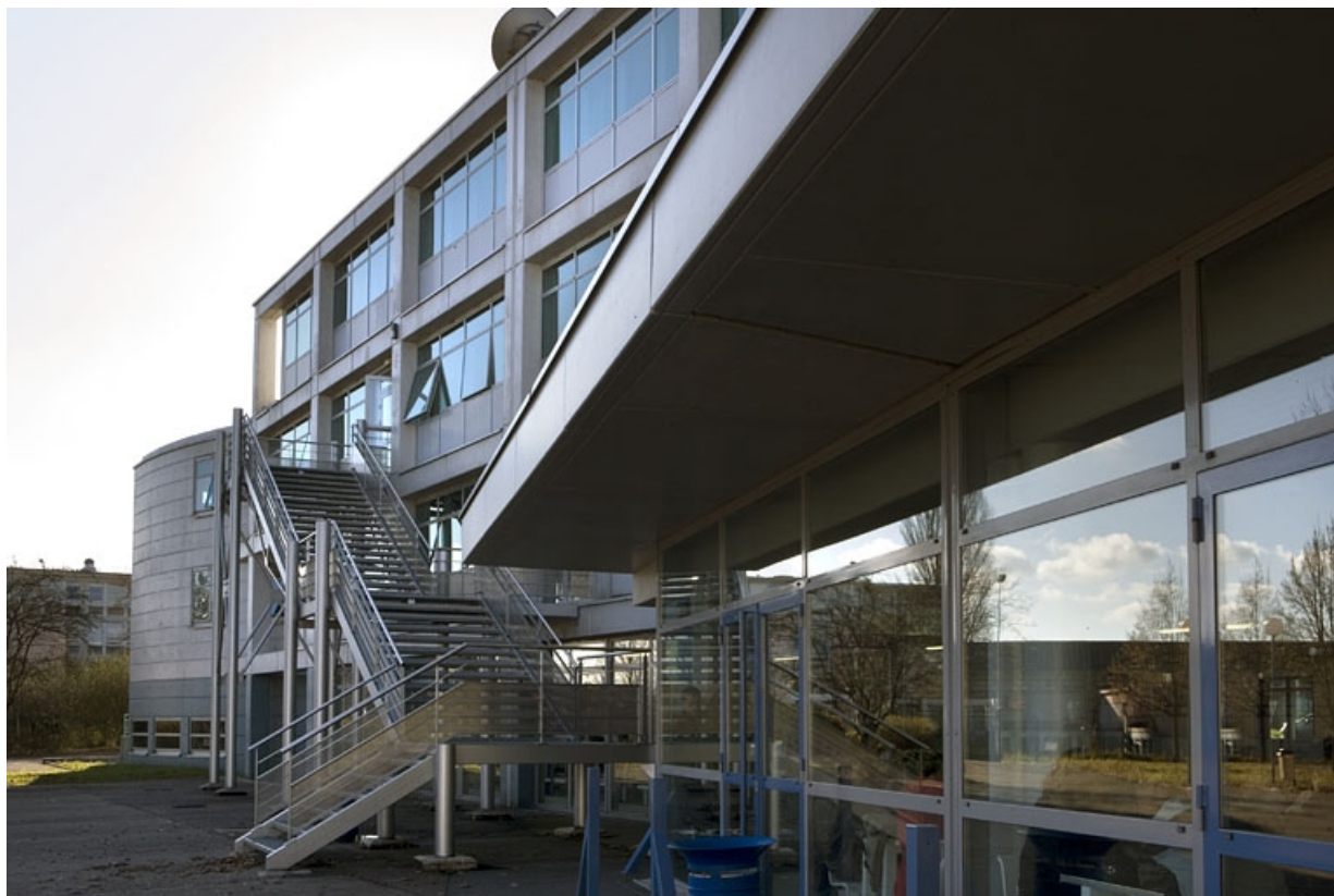
Bâtiment B. Vue latérale de la façade postérieure.
