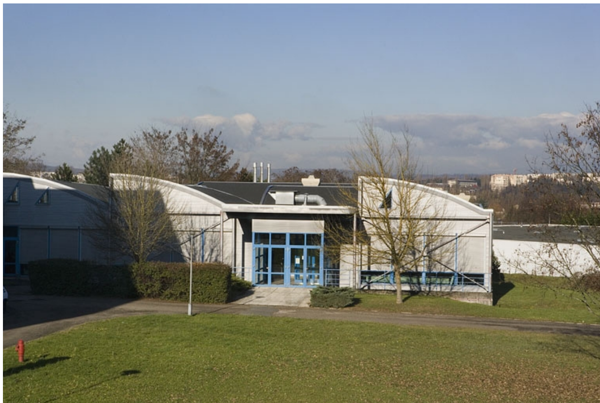
Vue du bâtiment R depuis la passerelle du bâtiment A.
