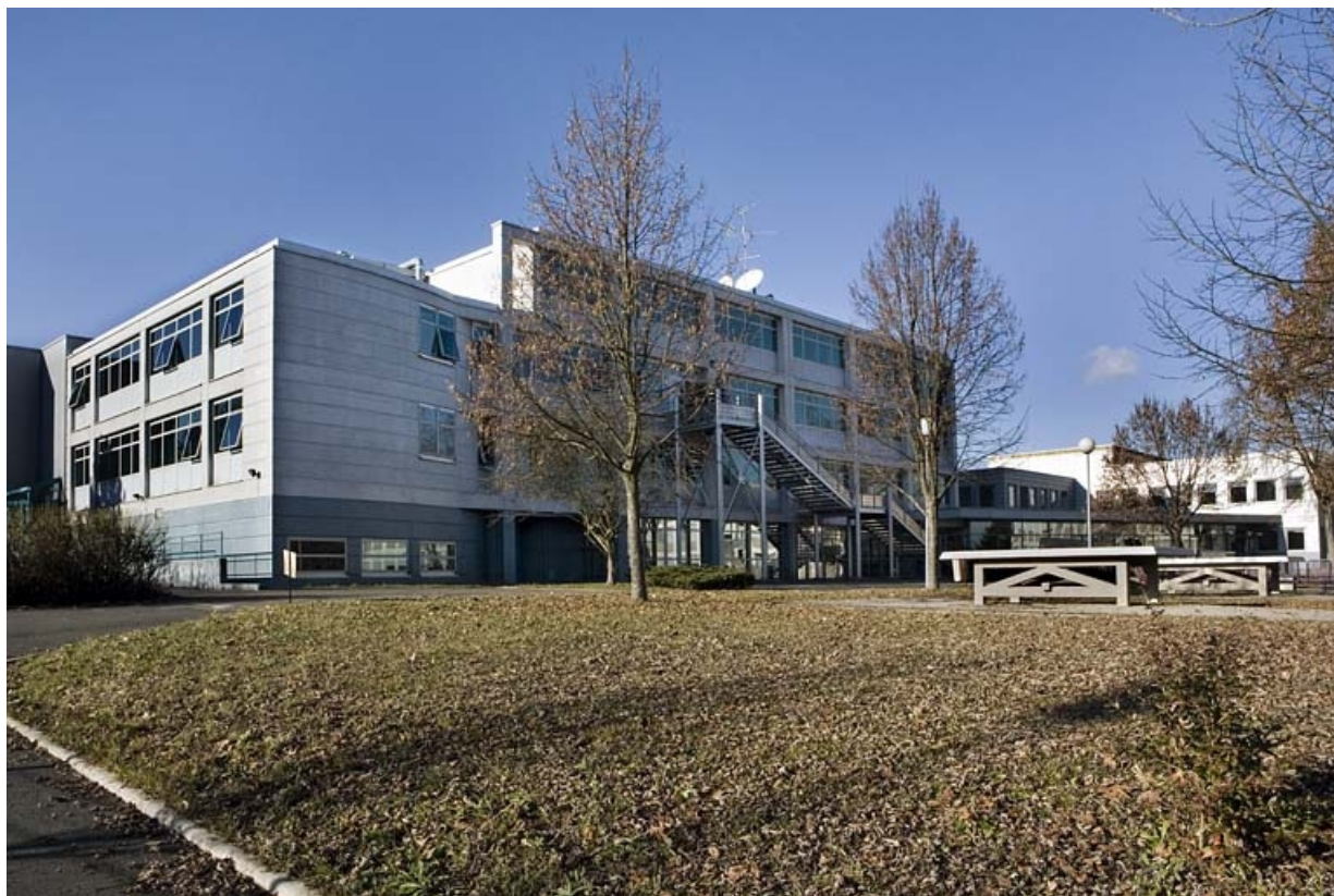
Bâtiment B. Vue de trois quarts gauche de la façade postérieure.
