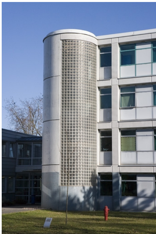
Bâtiment B. Détail de la travée d'escalier.
