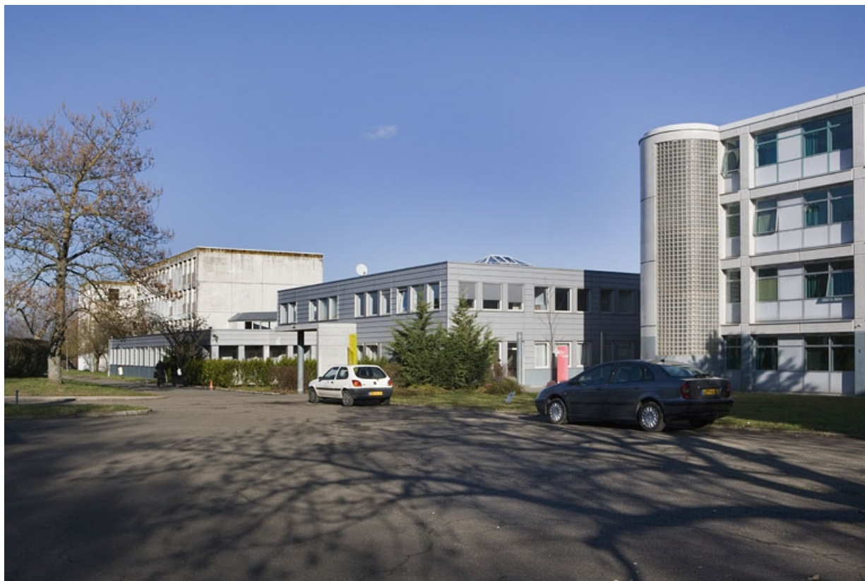
Vue d'ensemble depuis l'entrée principale. 25, Montbéliard rue Pierre Donzelot
