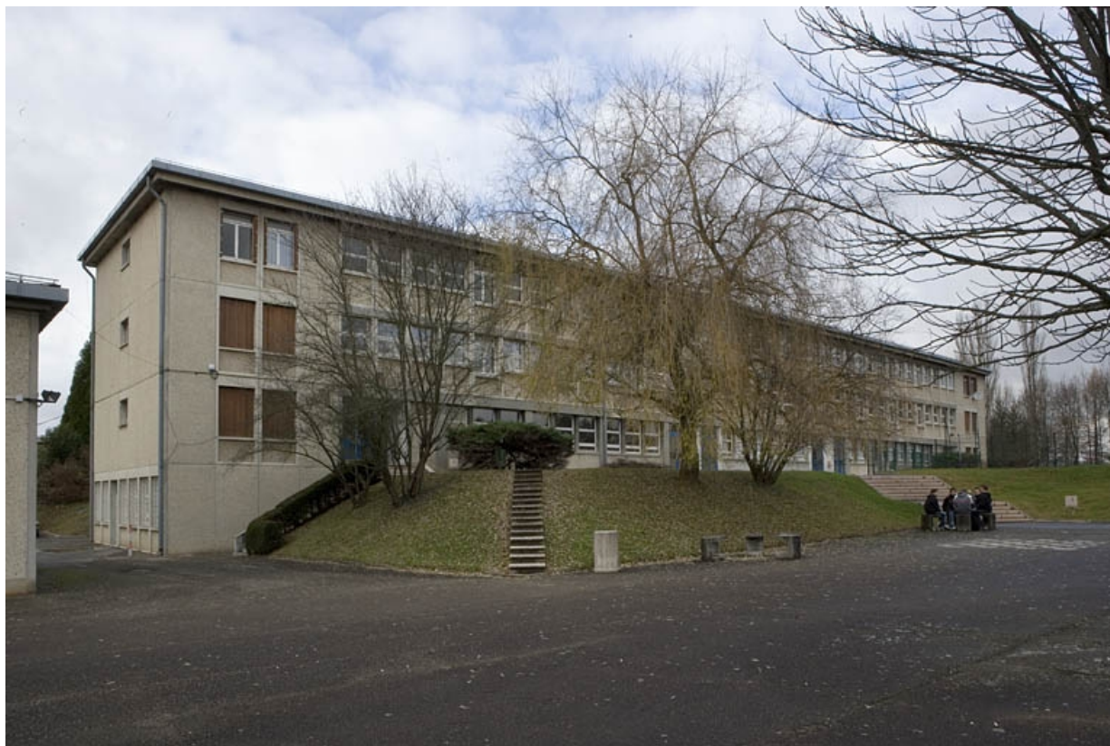
Vue façade antérieure bâtiment C.
