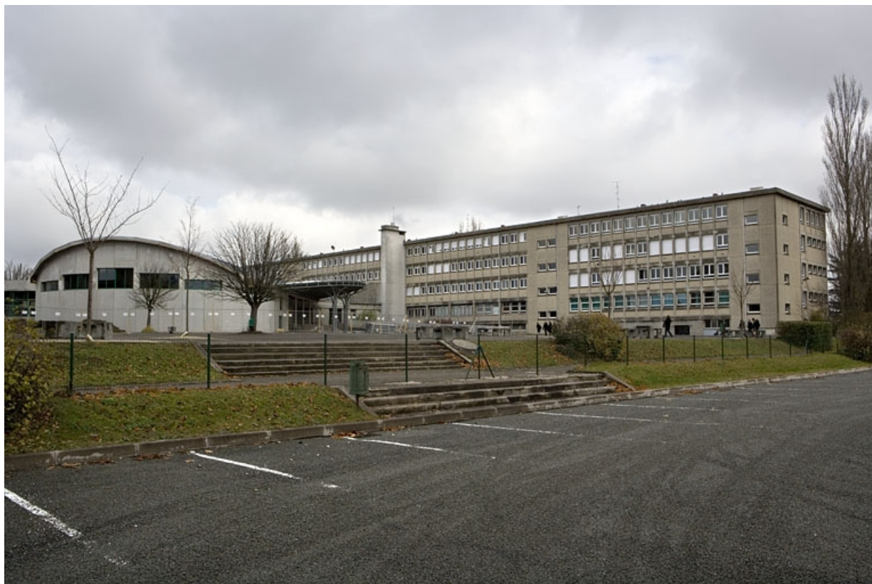
Vue de trois quarts droit du bâtiment A et bâtiment en construction.
