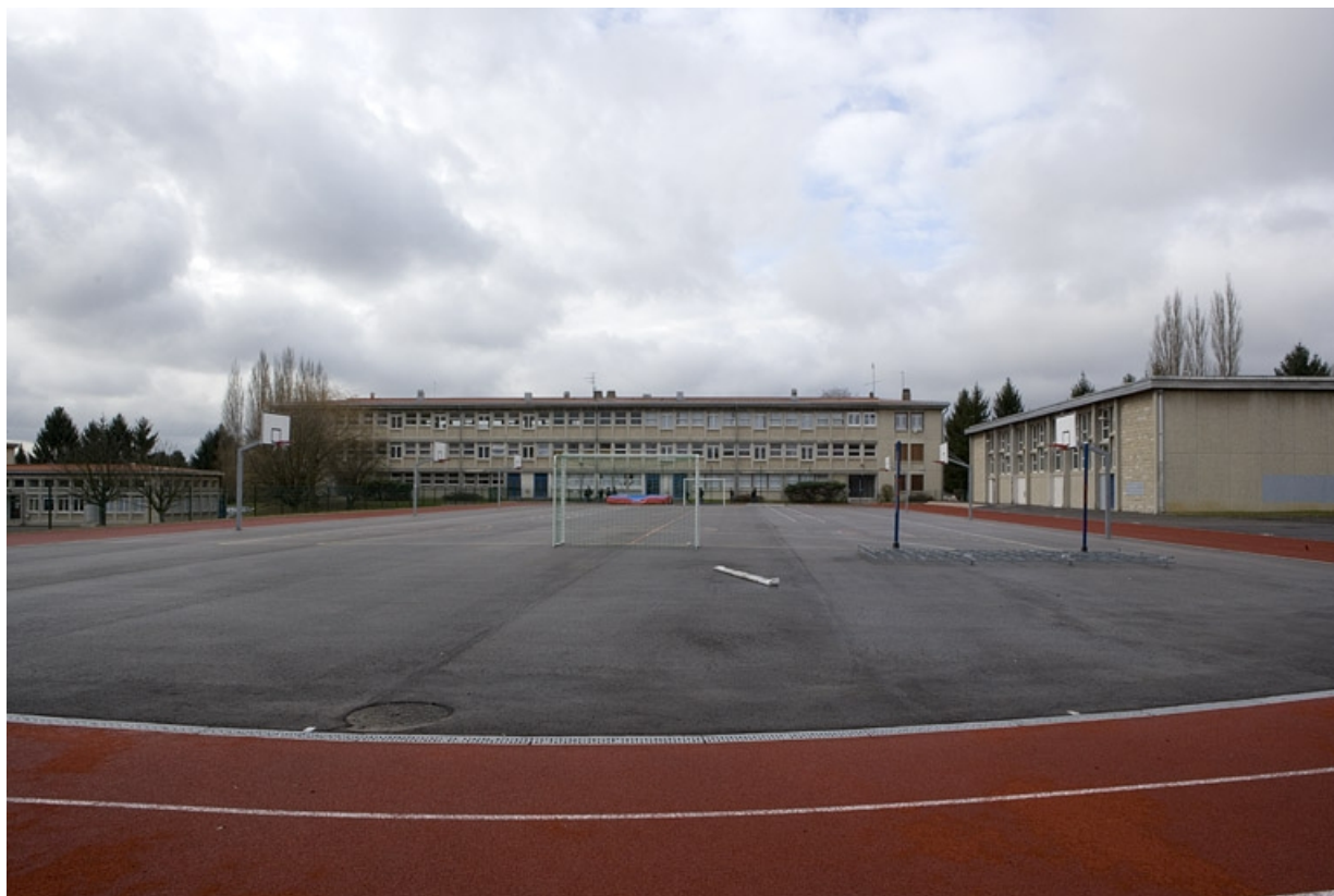
Vue d'ensemble bâtiment F2 et C.
