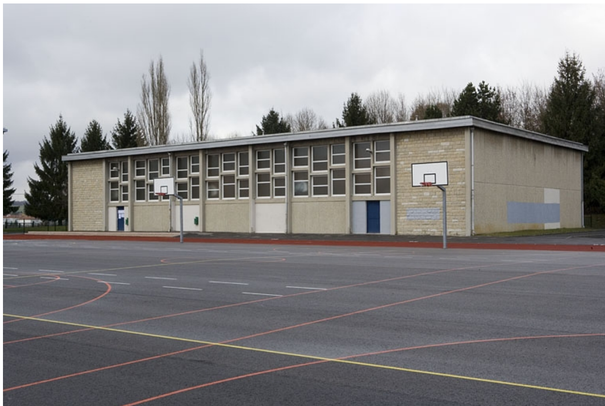
Vue de trois quarts droit du bâtiment F2.
