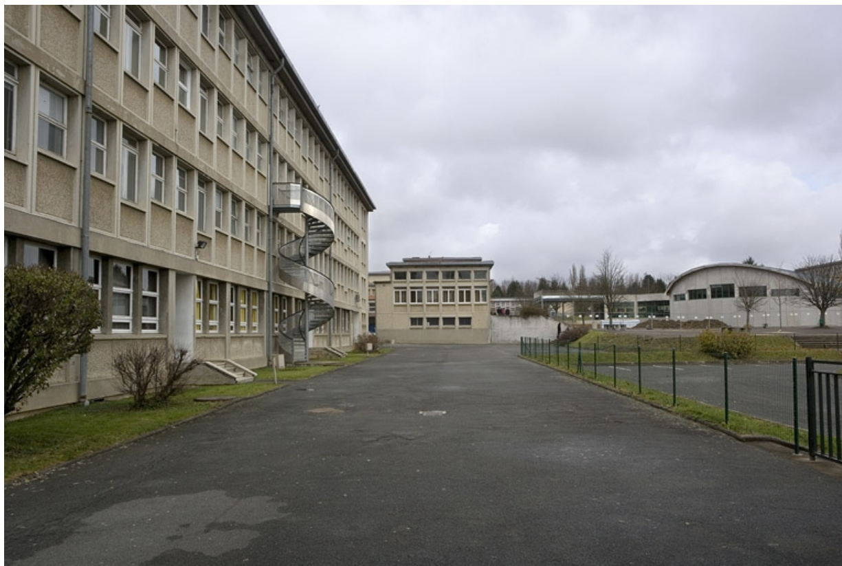
Vue latérale façade antérieure bâtiment D. 25, Montbéliard, 1 place Jean Monnet
