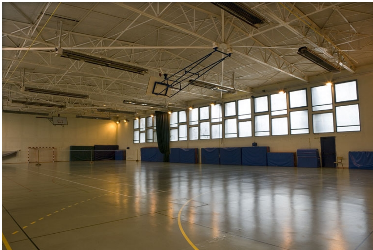
Bâtiment F1. Vue intérieure gymnase.
