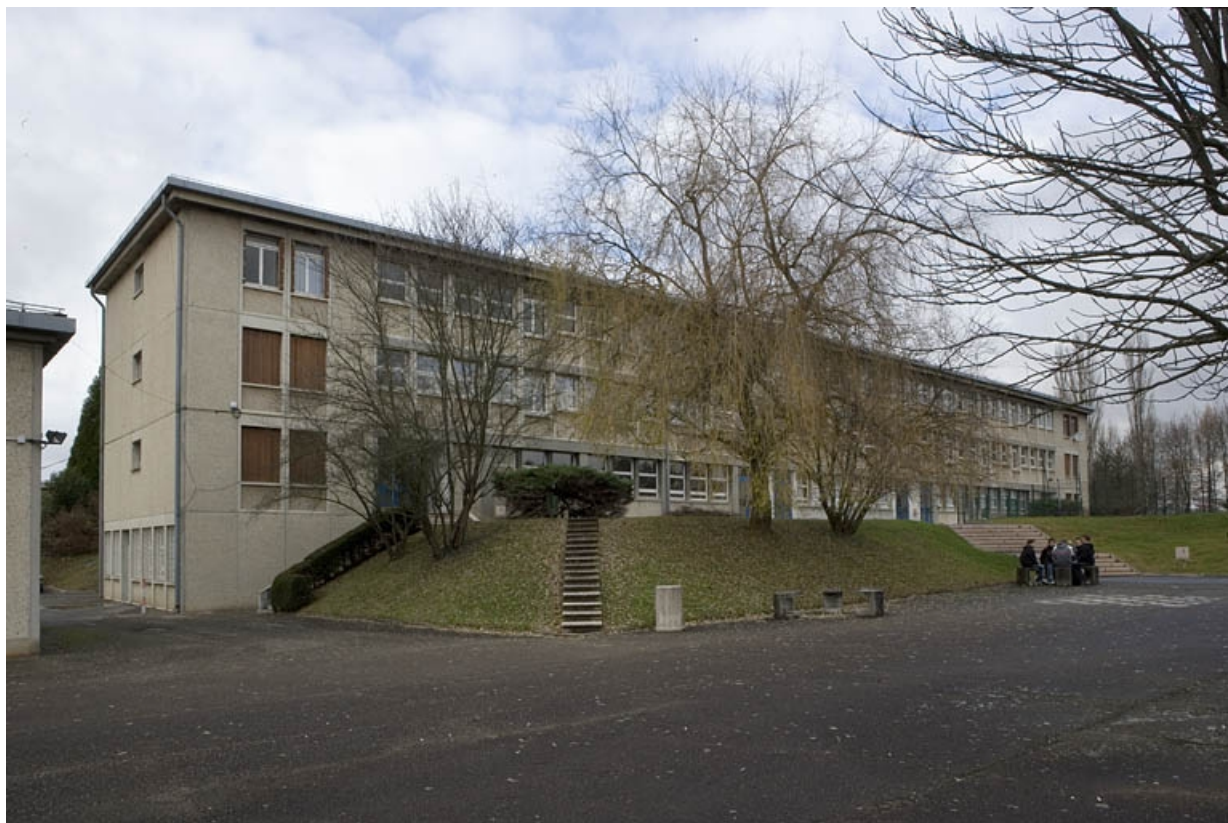
Vue façade antérieure bâtiment C.
