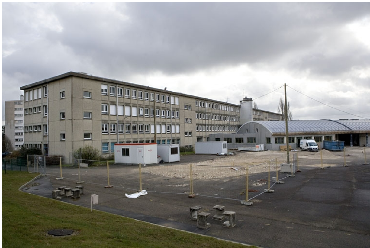
Vue de trois quarts gauche du bâtiment A et bâtiment en construction.
