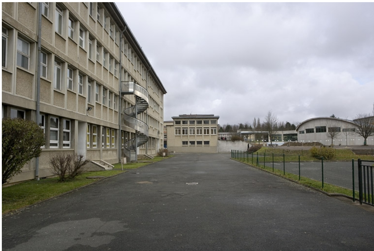
Vue latérale façade antérieure bâtiment D.
