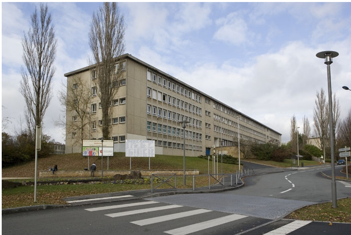
Vue de trois quarts gauche bâtiment A. Façade postérieure.
