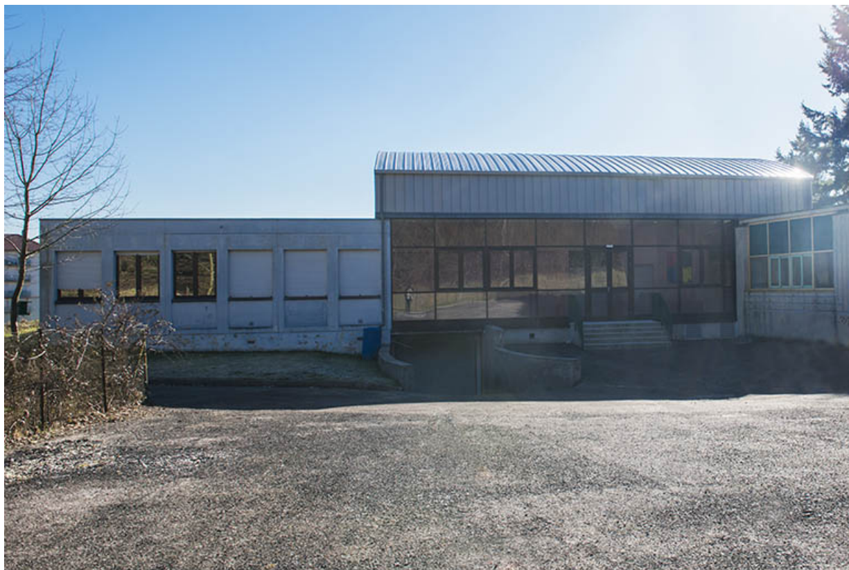
Façade nord-ouest de l'atelier
