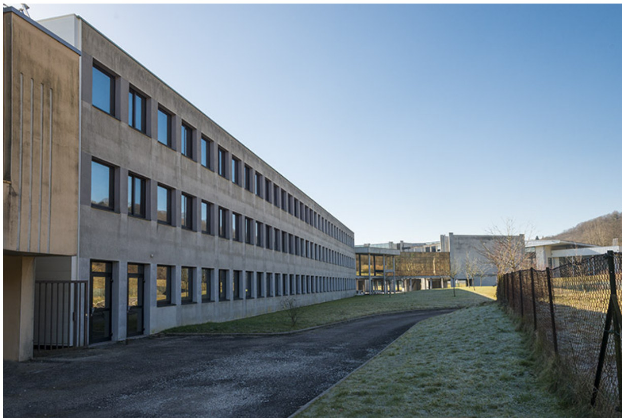
Façade ouest de l'enseignement scientifique.
