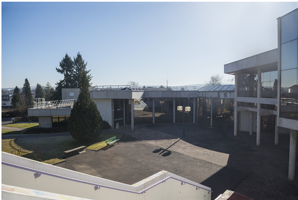
Cour, vue sur la façade ouest de l'administration.
