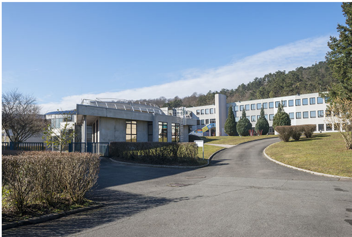
Depuis le nord-est vue sur les bâtiments d'administration et d'enseignement scientifique. 25, Valentigney, 30 rue des Carrières
