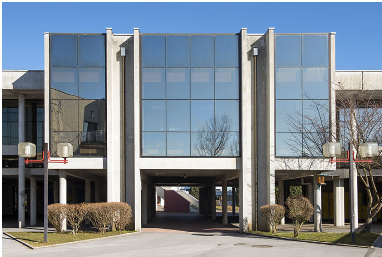
Vue de détail de la façade sud du bâtiment d'accueil.
