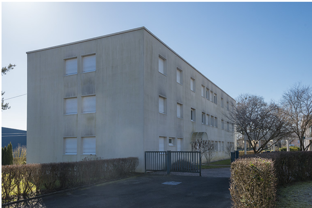
Pignon nord, angle nord-ouest du logement. 25, Valentigney, 30 rue des Carrières
