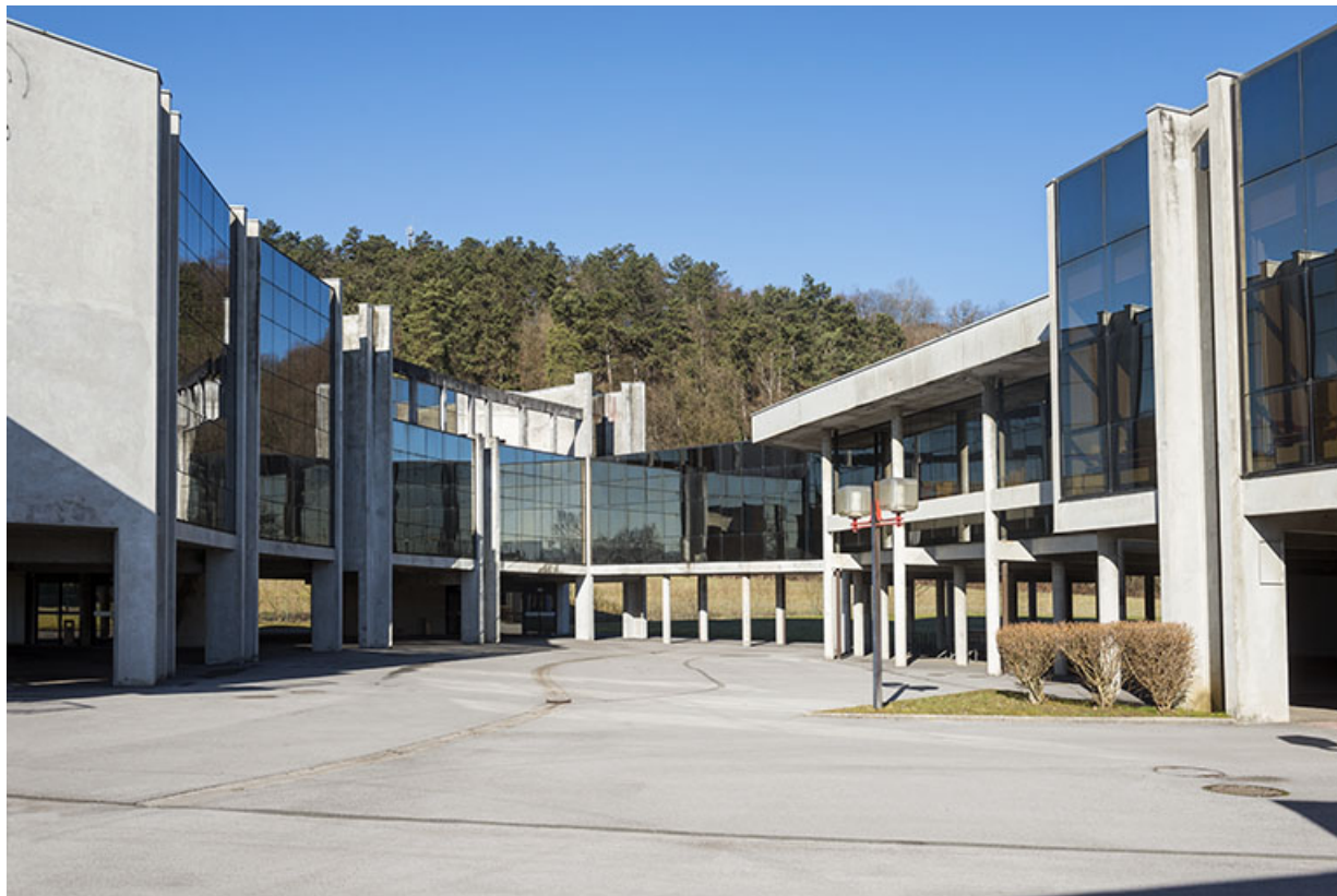
Cour sud, façade antérieure de l'externat sud, façade antérieure - sud - du bâtiment d'accueil. 25, Valentigney, 30 rue des Carrières
