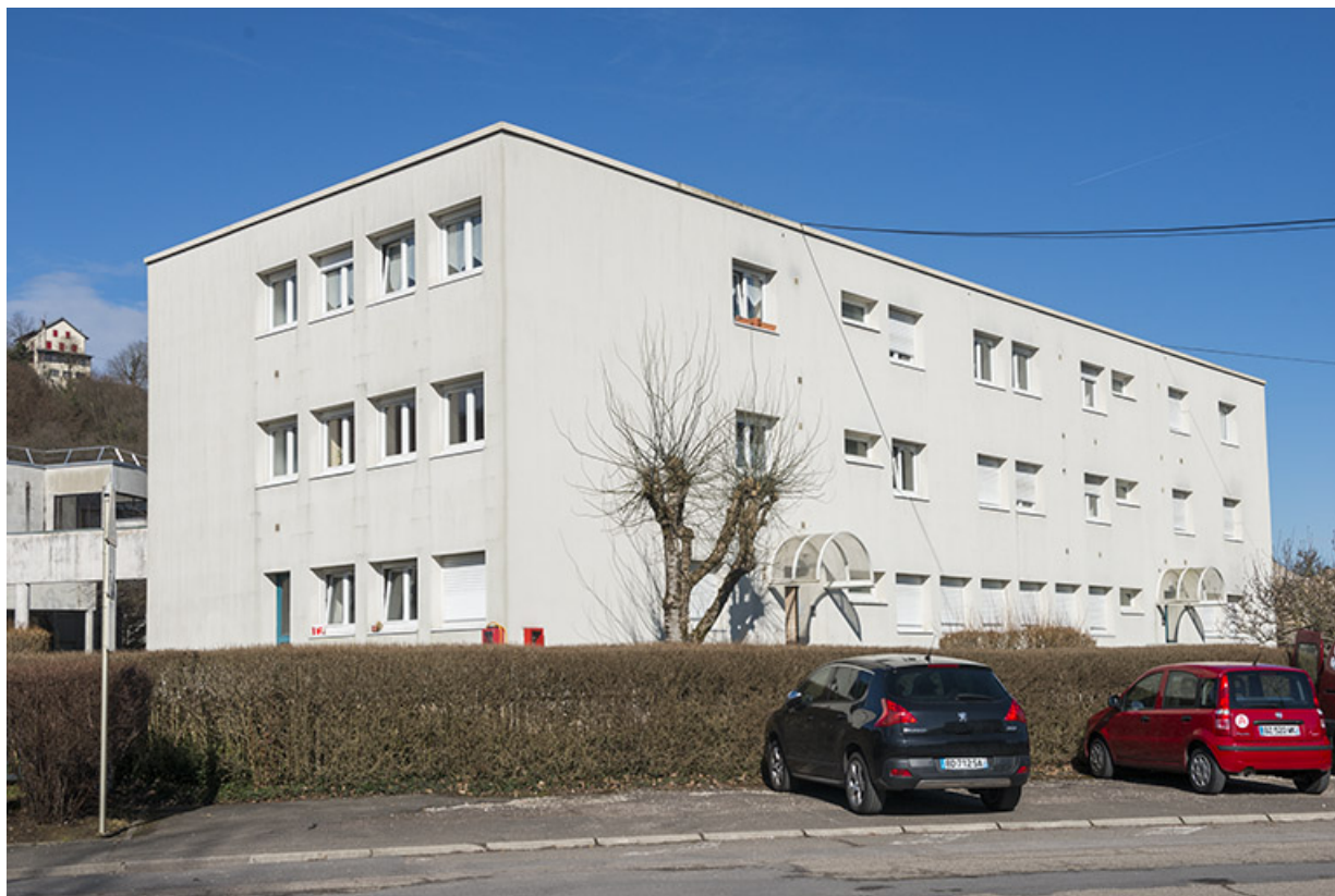
Angle sud-est du logement depuis la rue des carrières.
