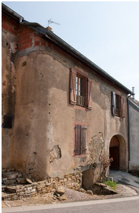
Vue rapprochée de la façade antérieure.
