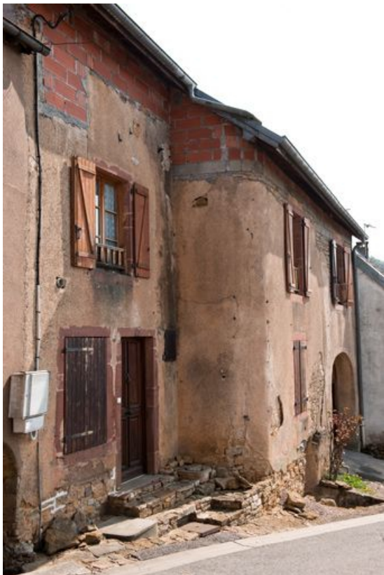
Façade antérieure, vue de trois quart gauche.
