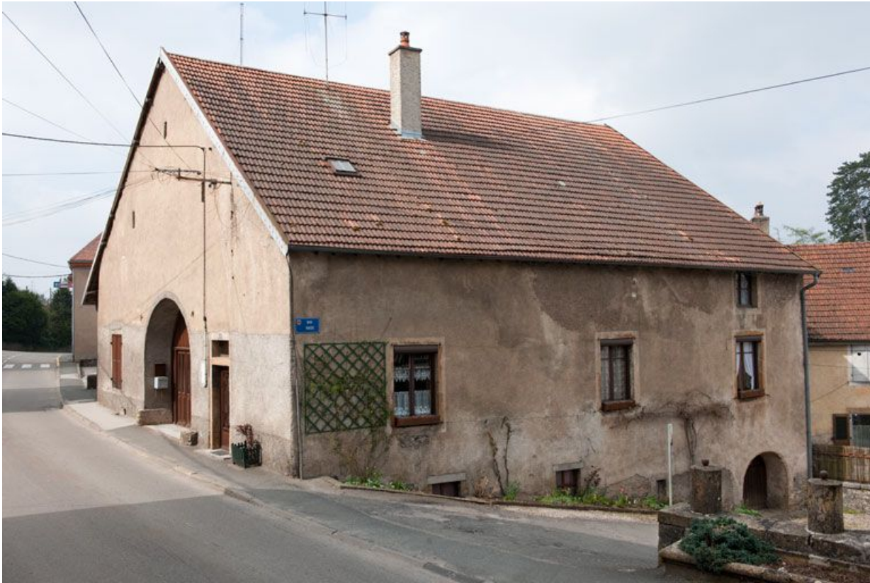
Façade antérieure et façade latérale droite.
