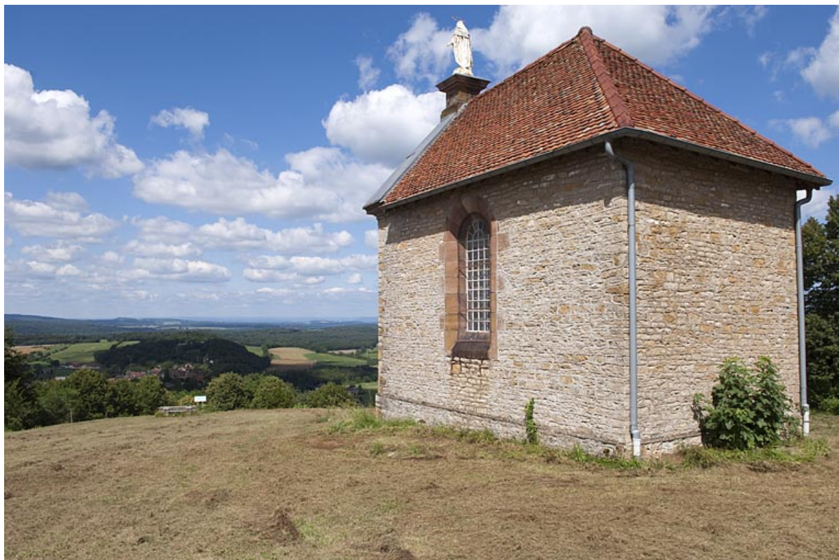
Vue du chevt et de la façade latérale droite.
