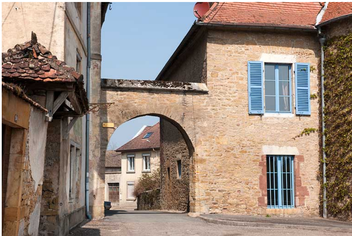
Vue rapprochée de la porte du Vieux Moulin et de la maison du Vieux Moulin. 25, Rougemont
