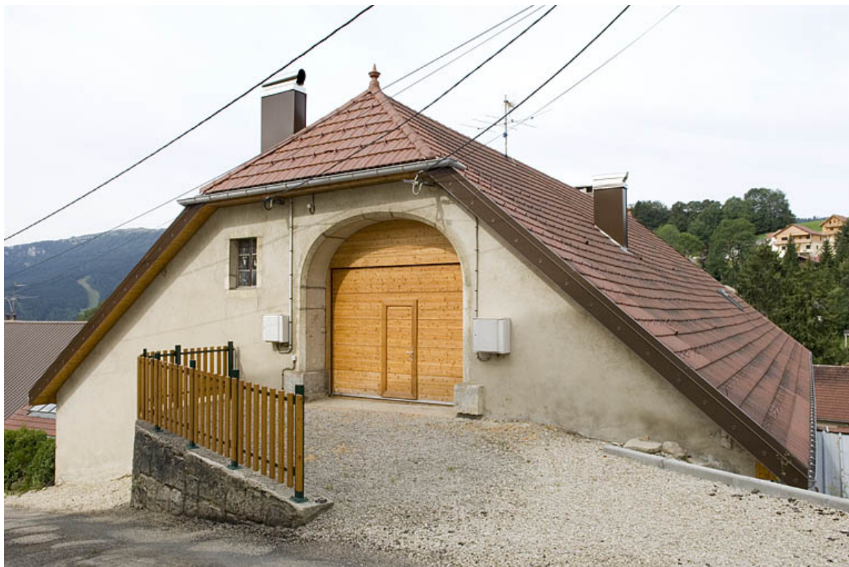
Façade latérale gauche et le pont de l'ancienne grange, rue du Châtelet. 25, Jougne, 16 rue de l' Eglise
