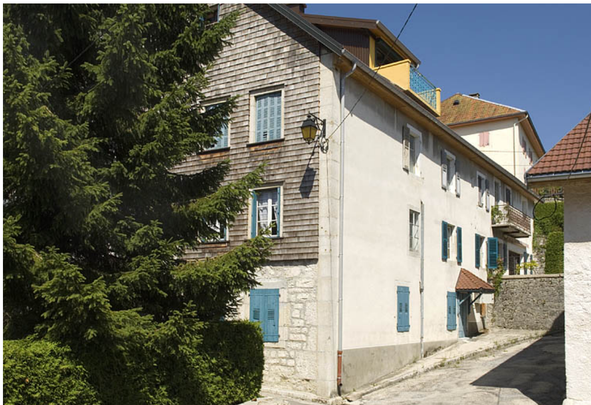
Façade latérale droite et façade postérieure.
