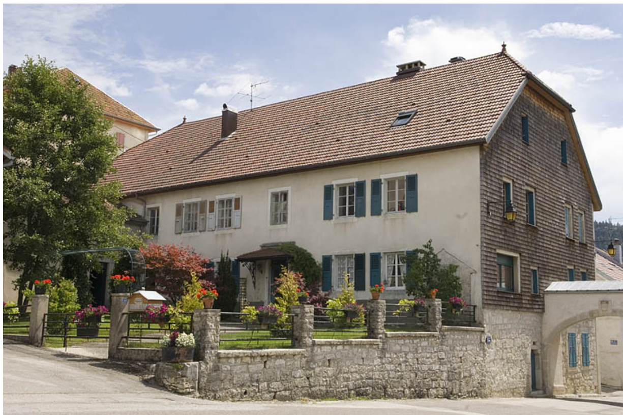
Façade antérieure et façade latérale droite.
