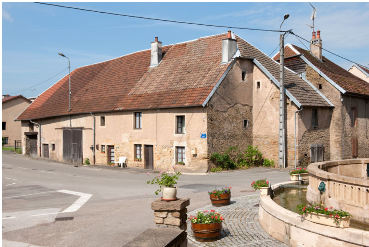
Vue générale depuis la rue de l'Ancien Cimetière.
