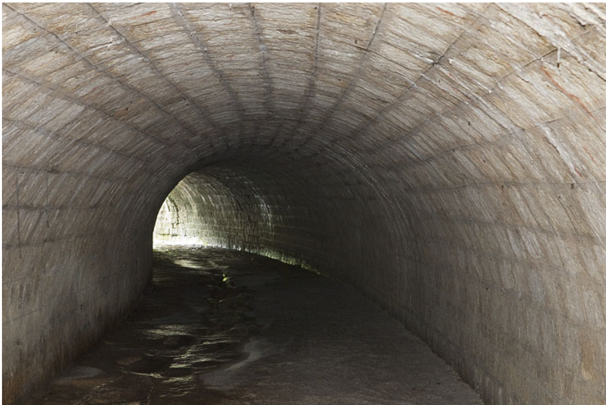
Intérieur du pont, aqueduc du Vaubillon (n°6) en direction de La Ferrière. 25, Jougne
