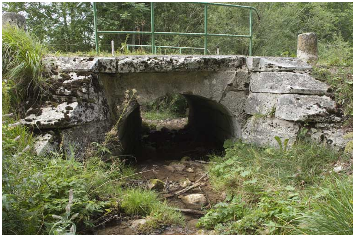
Pont du ruisseau de la Goulette ( n°18), vue depuis l'amont. 25, Jougne
