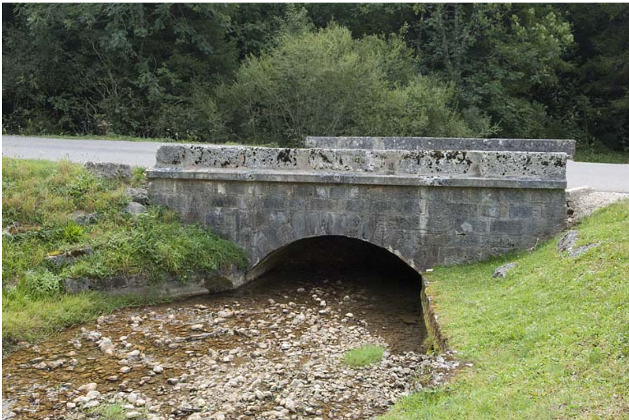
Pont sur la Jougna (n°4), vue depuis l'amont. 25, Jougne
