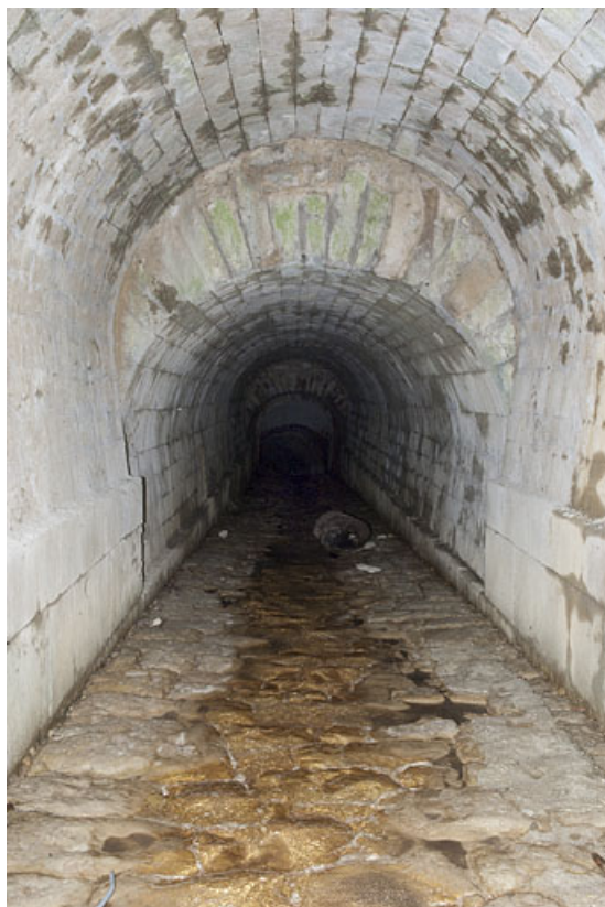
Détail de la voûte du pont, aqueduc du Vaubillon (n°6). 25, Jougne
