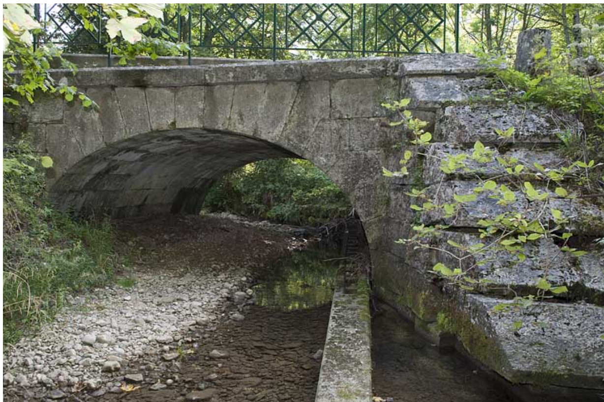
Pont sur la Jougnana (n°3), vue depuis l'amont. 25, Jougne
