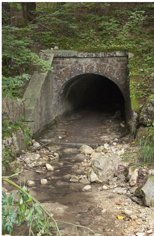
L'entrée du pont, aqueduc du Vaubillon (n°6), aux Tavins. 25, Jougne
