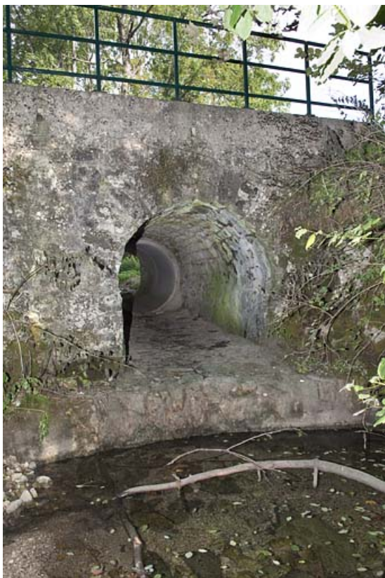
Pont sur la Servante (n°5), vue depuis l'aval. 25, Jougne
