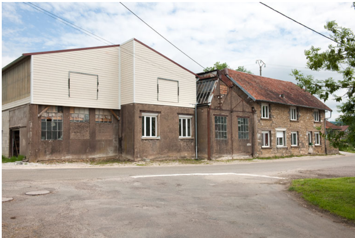
Vue générale depuis le Chemin du Souvenir Français.
