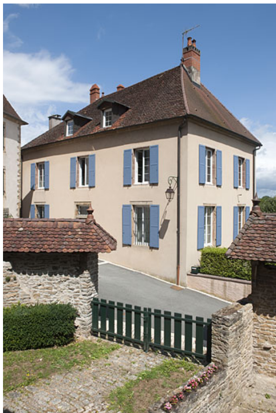
Vue générale depuis la cour des communs.
