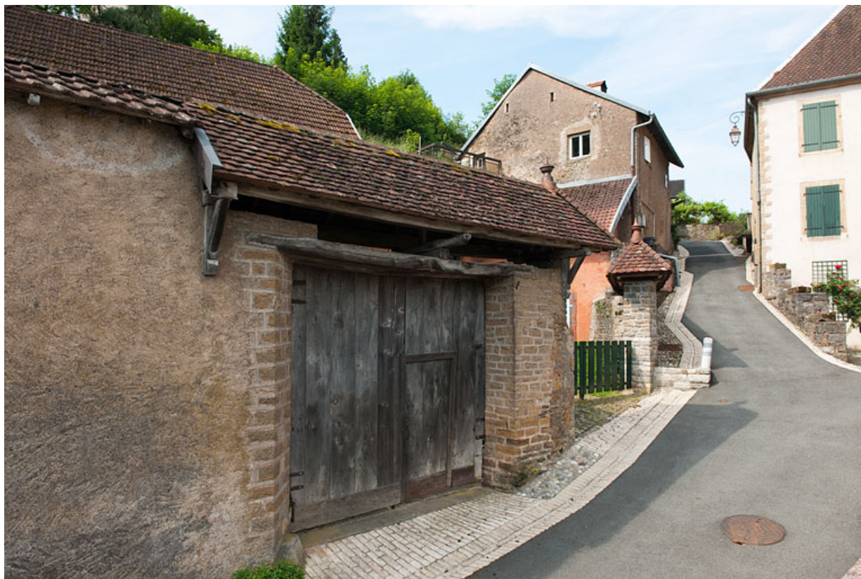
Vue des communs et de la demeure depuis la rue de la Petite Côte.
