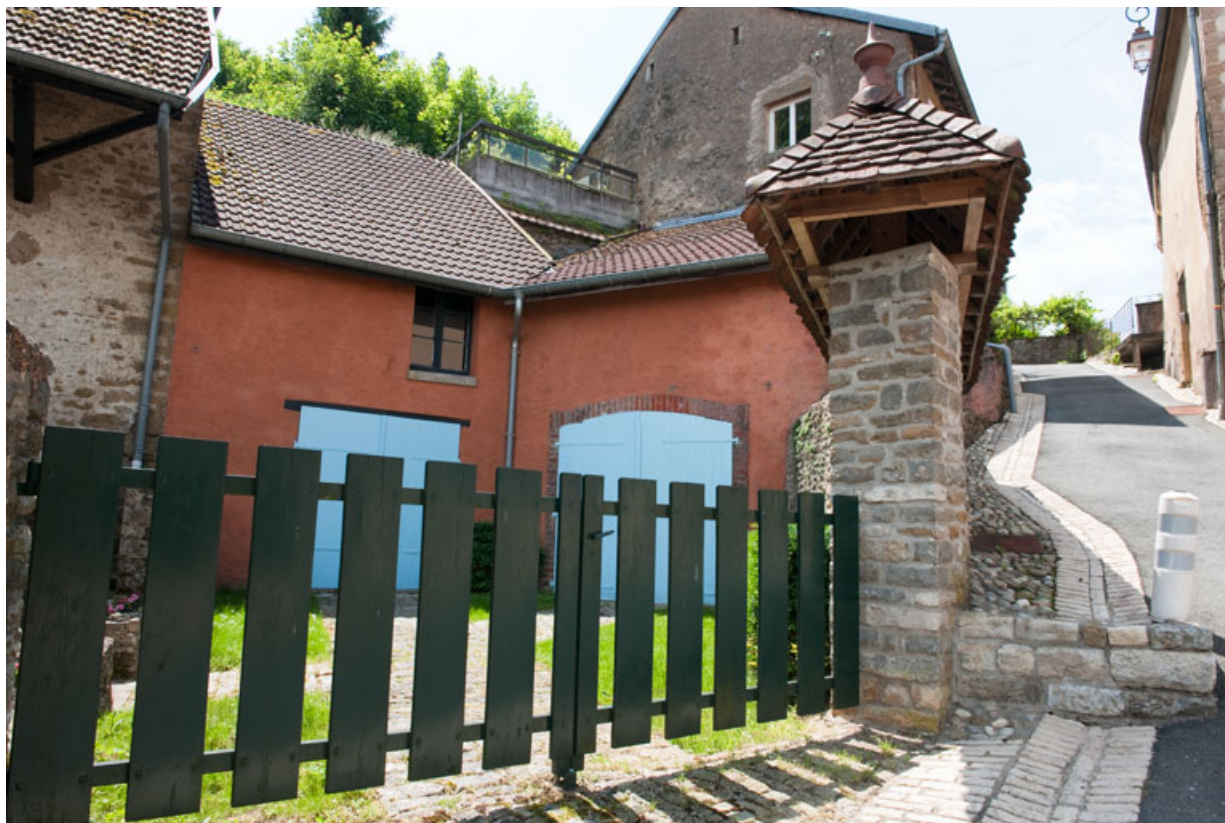
Vue d'ensemble des constructions abritant les caves.
