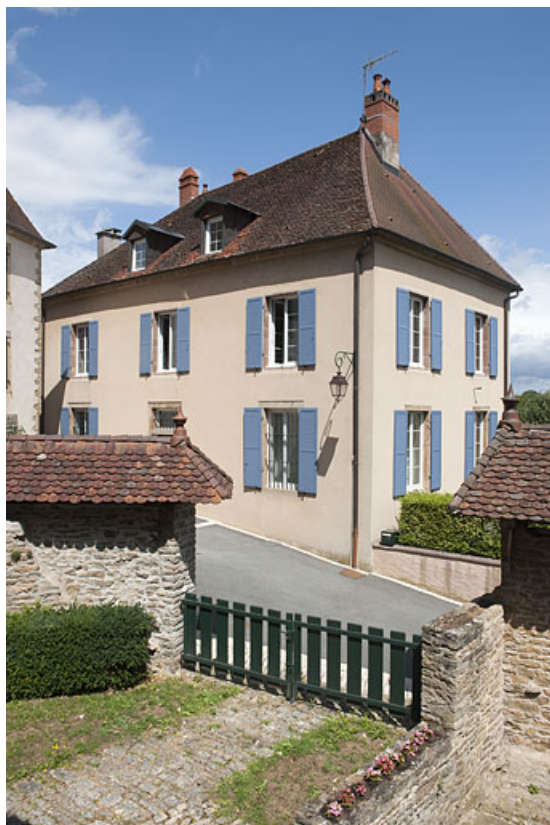
Vue générale depuis la cour des communs.
