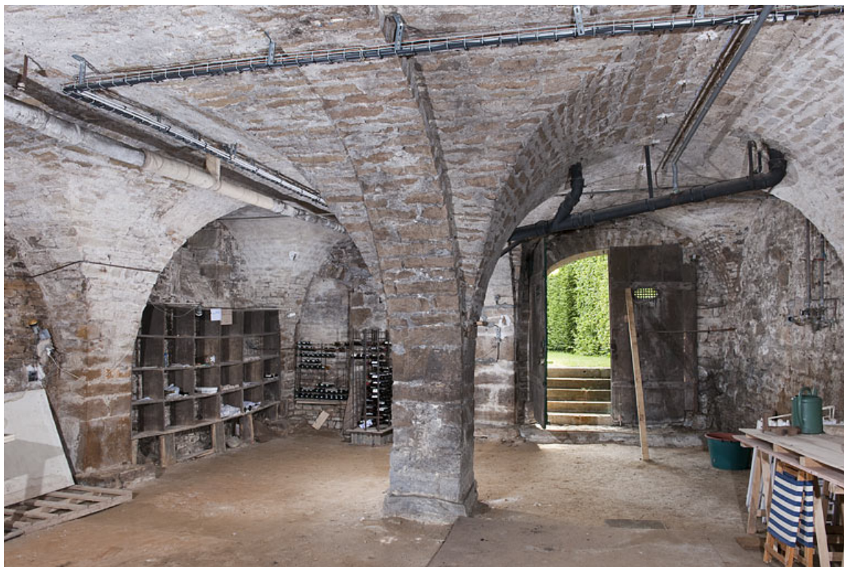
Vue générale du sous-sol.
