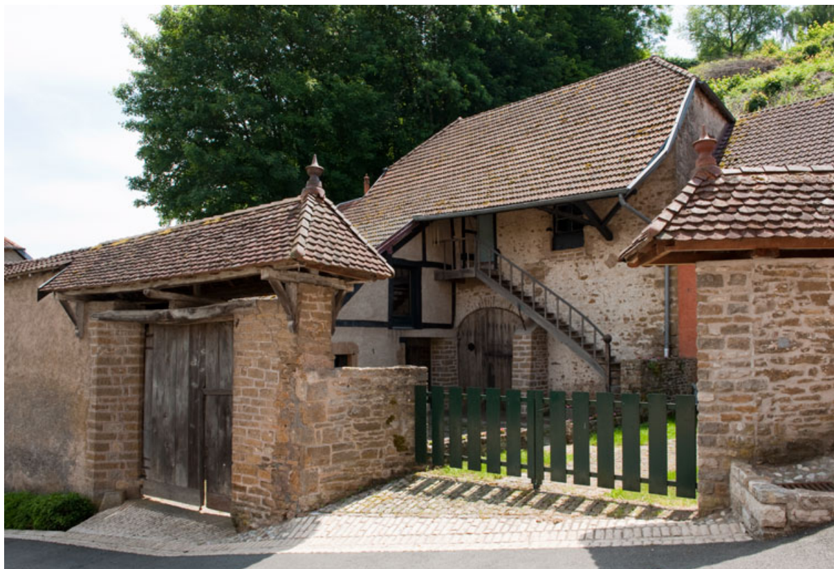
Vue des communs depuis la rue de la Petite Côte.
