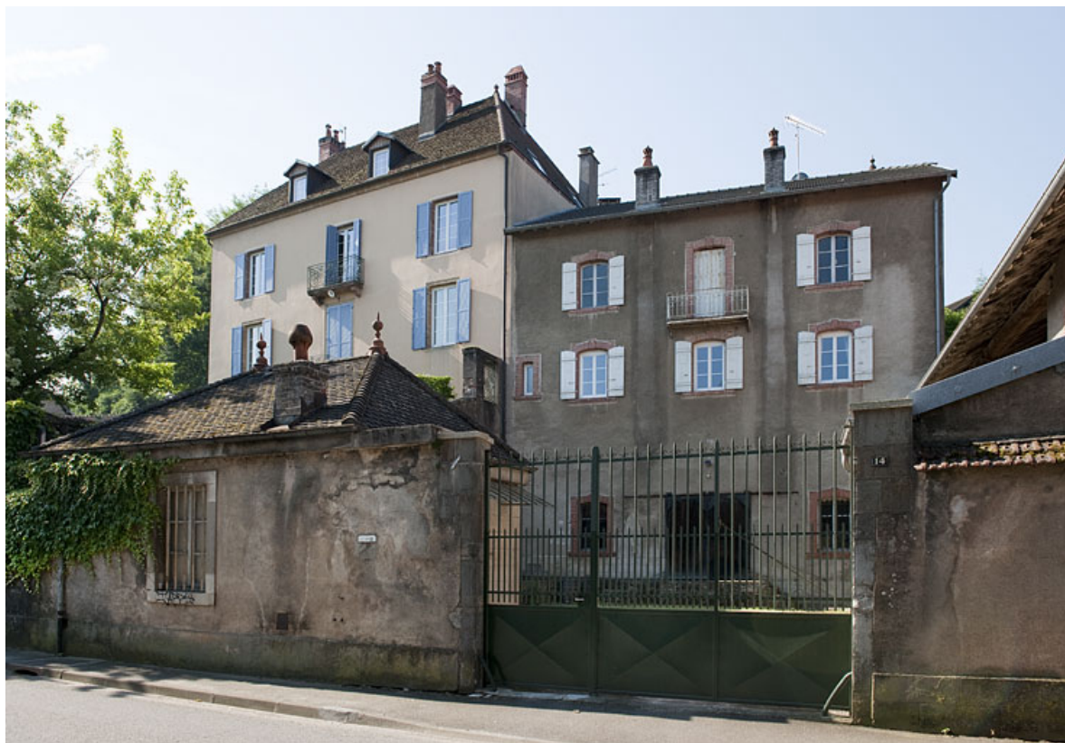
Vue d'ensemble de la demeure et de la maison de négociant Bichet rue du Vieux Moulin.
