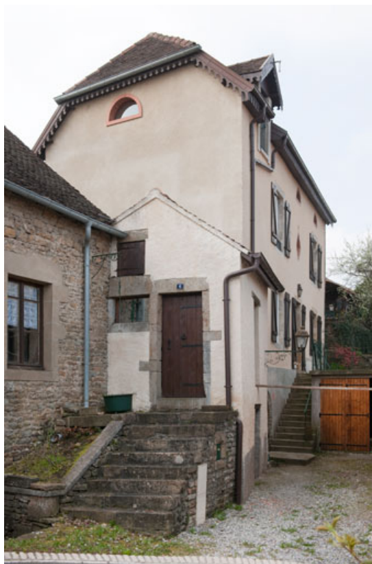
Habitation : façade latérale gauche et façade antérieure.
