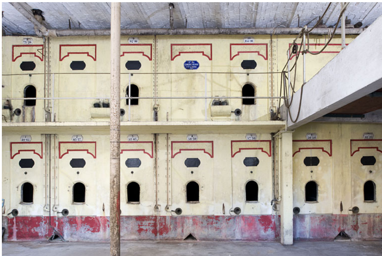
Intérieur de l'entrepôt : vue d'ensemble des caves depuis l'entrée.
