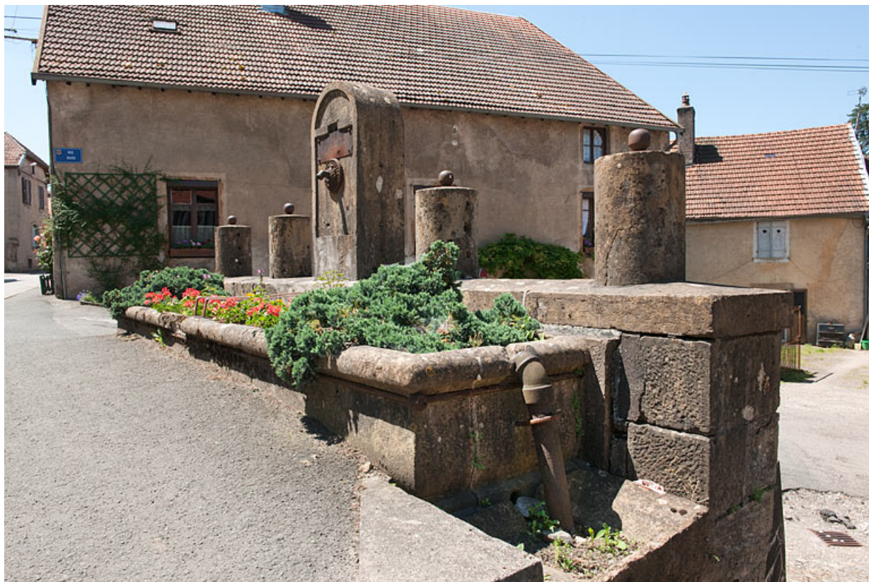
Vue de trois quarts droit. 25, Rougemont Grande Rue
