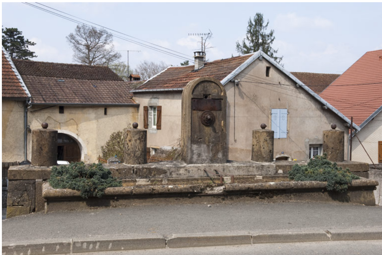
Vue générale, de trois quarts gauche. 25, Rougemont Grande Rue
