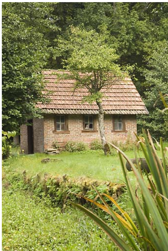
Remise : vue d'ensemble, depuis le sud.
