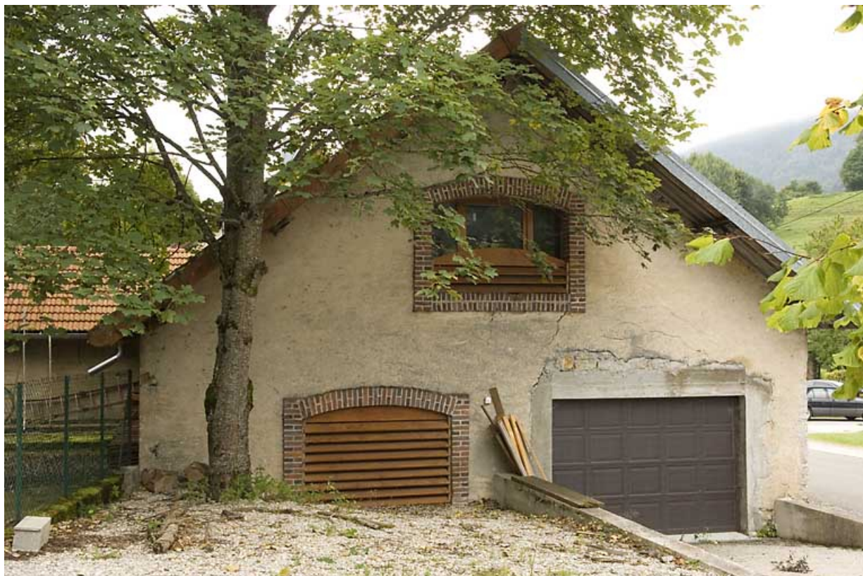
Usine : façade latérale gauche.
