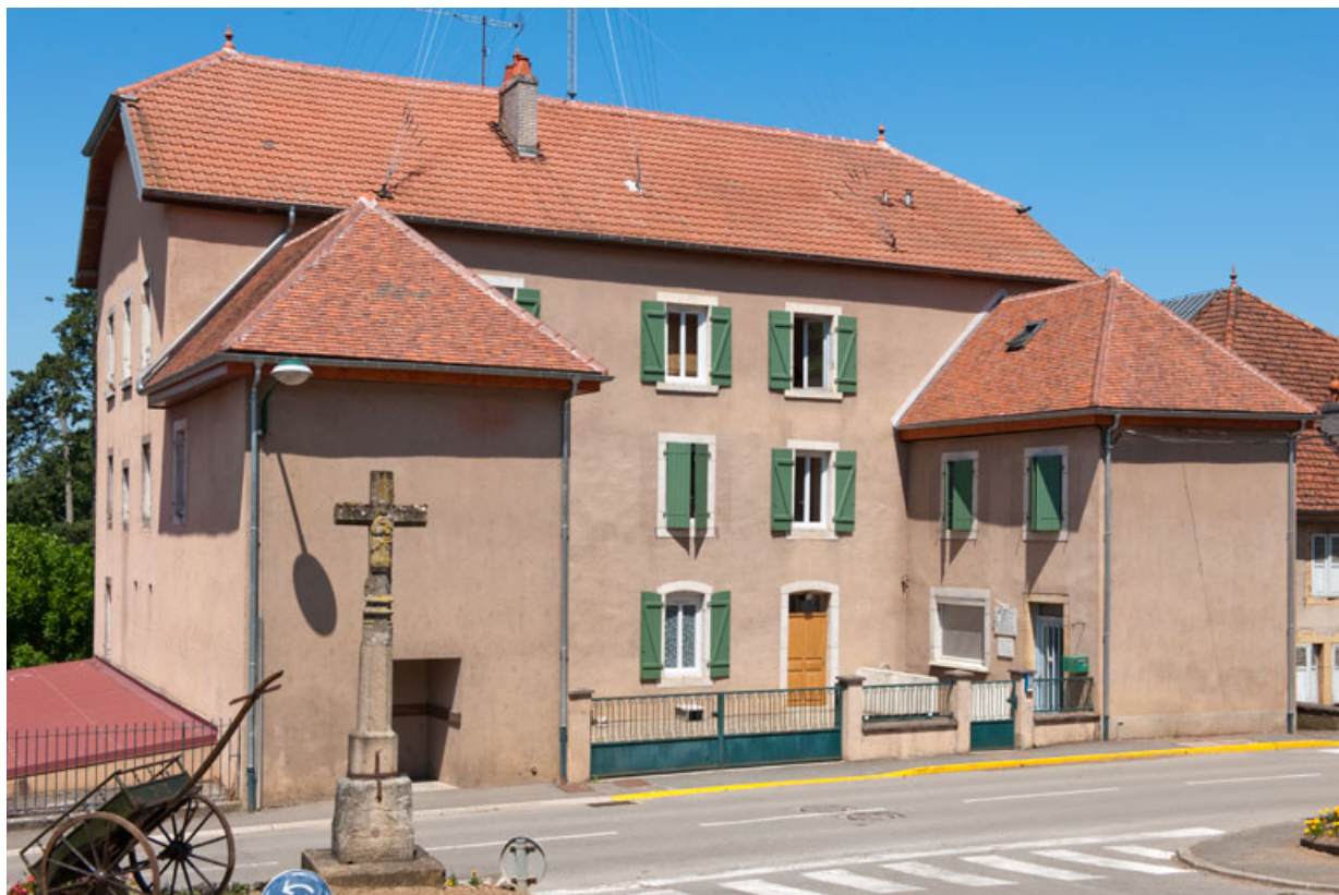
Vue générale rapprochée de trois quart gauche. 25, Rougemont, 30 Grande Rue
