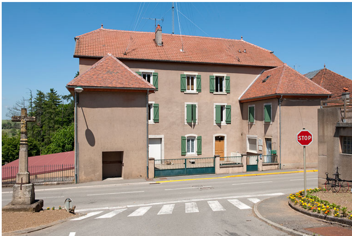
Vue générale depuis le bas de la grande Côte. 25, Rougemont, 30 Grande Rue
