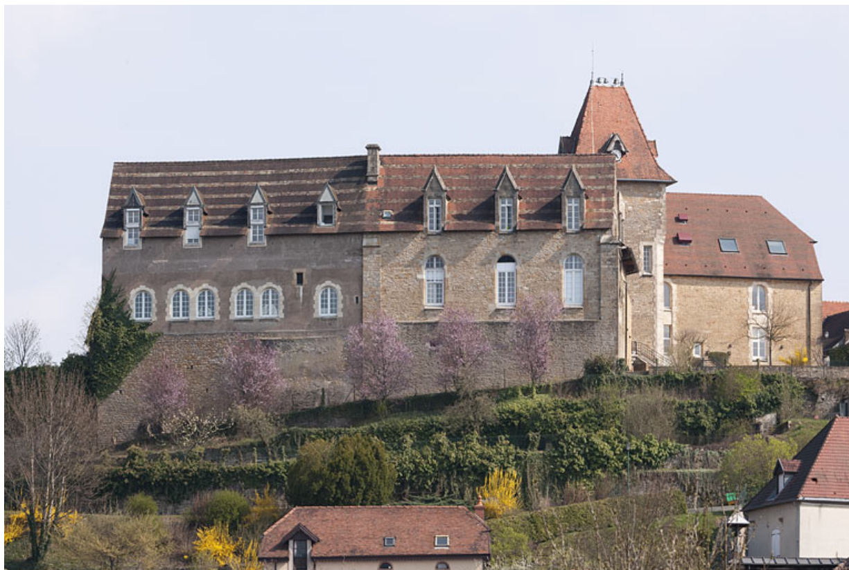
Bâtiment (C) et chapelle (D), vue depuis le village. 25, Jougne
