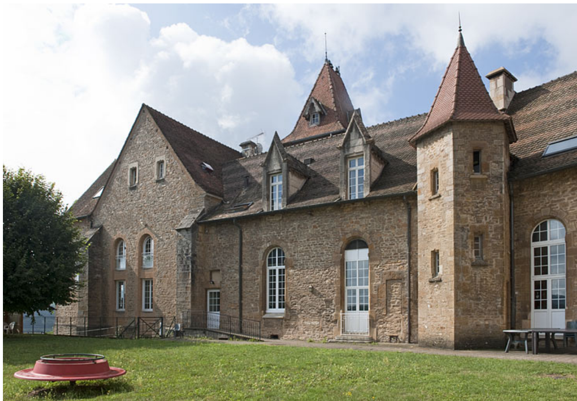
Bâtiment (C), côté jardin.
