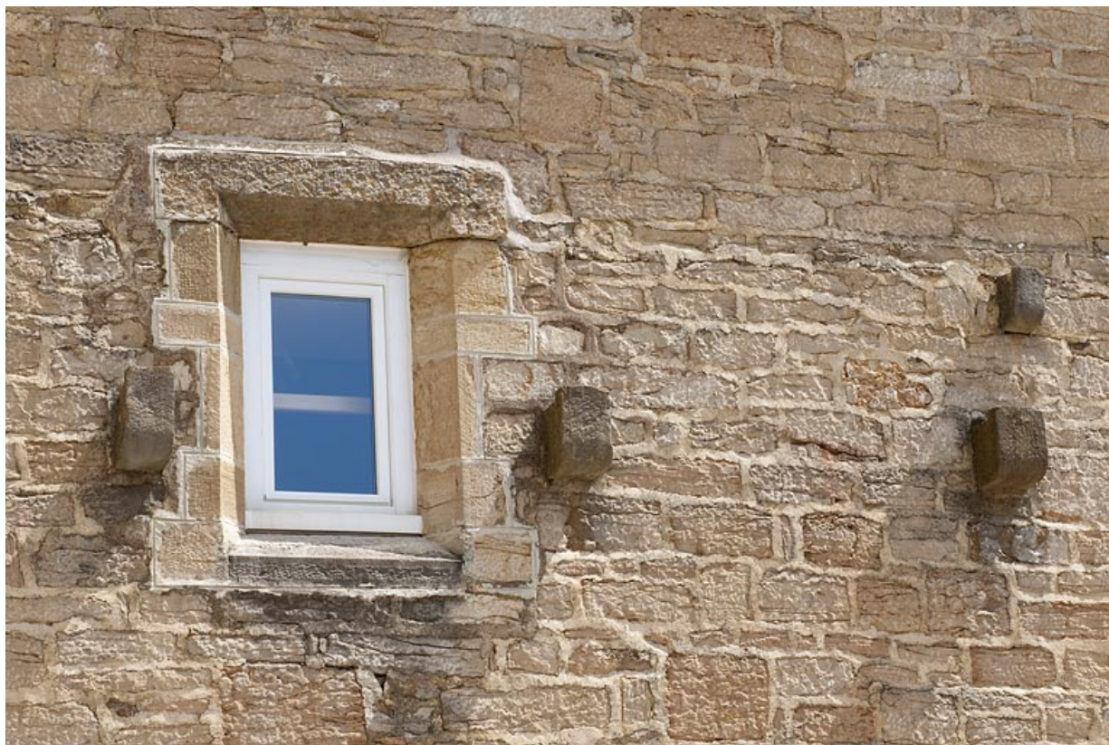
Chapelle (F), vue d'une baie.
