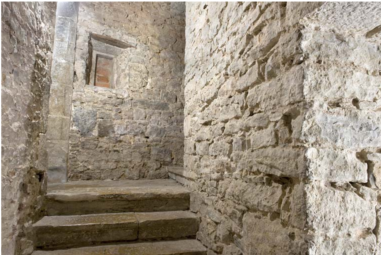
Escalier dans-oeuvre desservant les étages.
