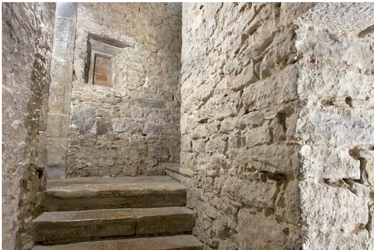
Escalier dans-oeuvre desservant les étages.
