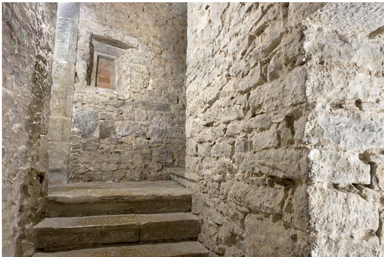
Escalier dans-oeuvre desservant les étages.
