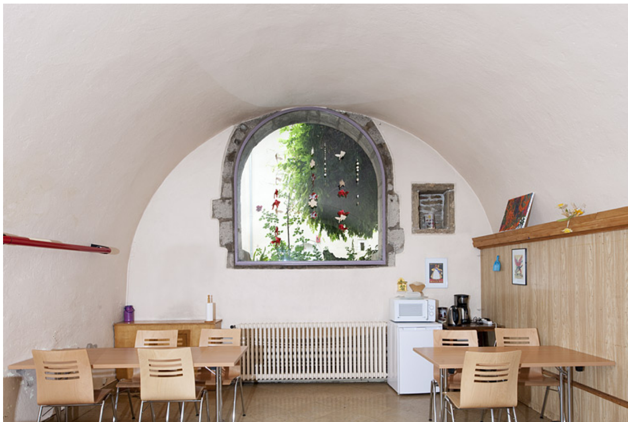
Hôtel de Choiseul : ancienne cave voûtée en berceau, vue en direction de la cour. 25, Rougemont, 6, 8 rue Basse
