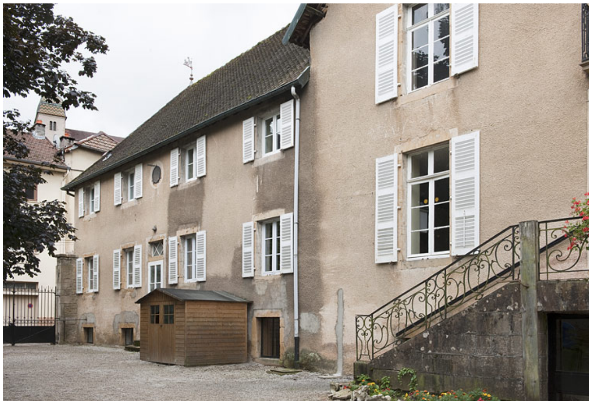
Revers des façades sur cour secondaire.
