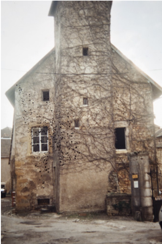
Bâtiment : élévation du côté de la rue Basse, après l'incendie (vers 2000). 25, Rougemont, 6, 8 rue Basse
