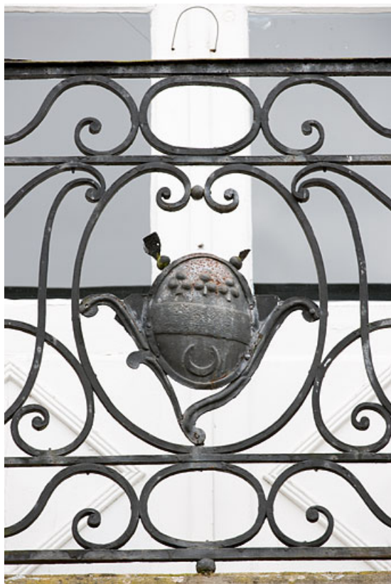
Détail du garde corps du balconnet du 1er étage, côté rue des Fossés. 25, Rougemont, 6, 8 rue Basse
