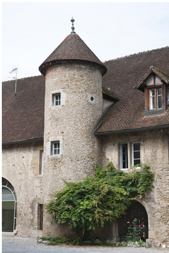
La tour d'escalier de l'hôtel de Choiseul.
