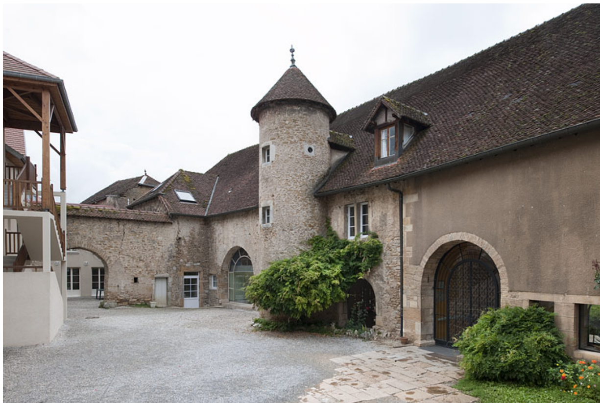
Vue d'ensemble des bâtiments de la cour principale.
