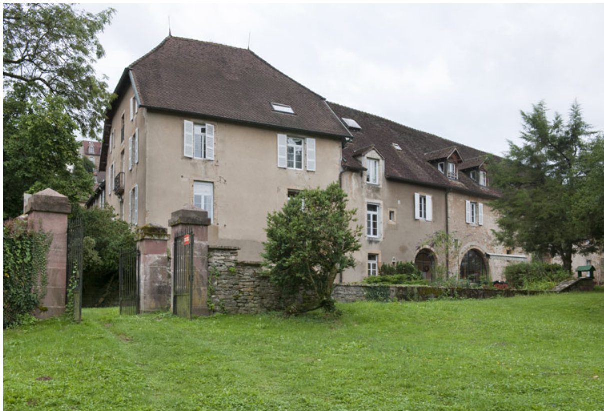
Vue rapprochée des façades, côté rue des Fossés.
