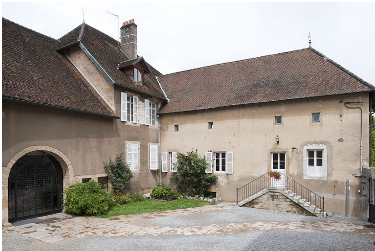
Vue générale des bâtiments, à droite de l'entrée de la cour principale.
