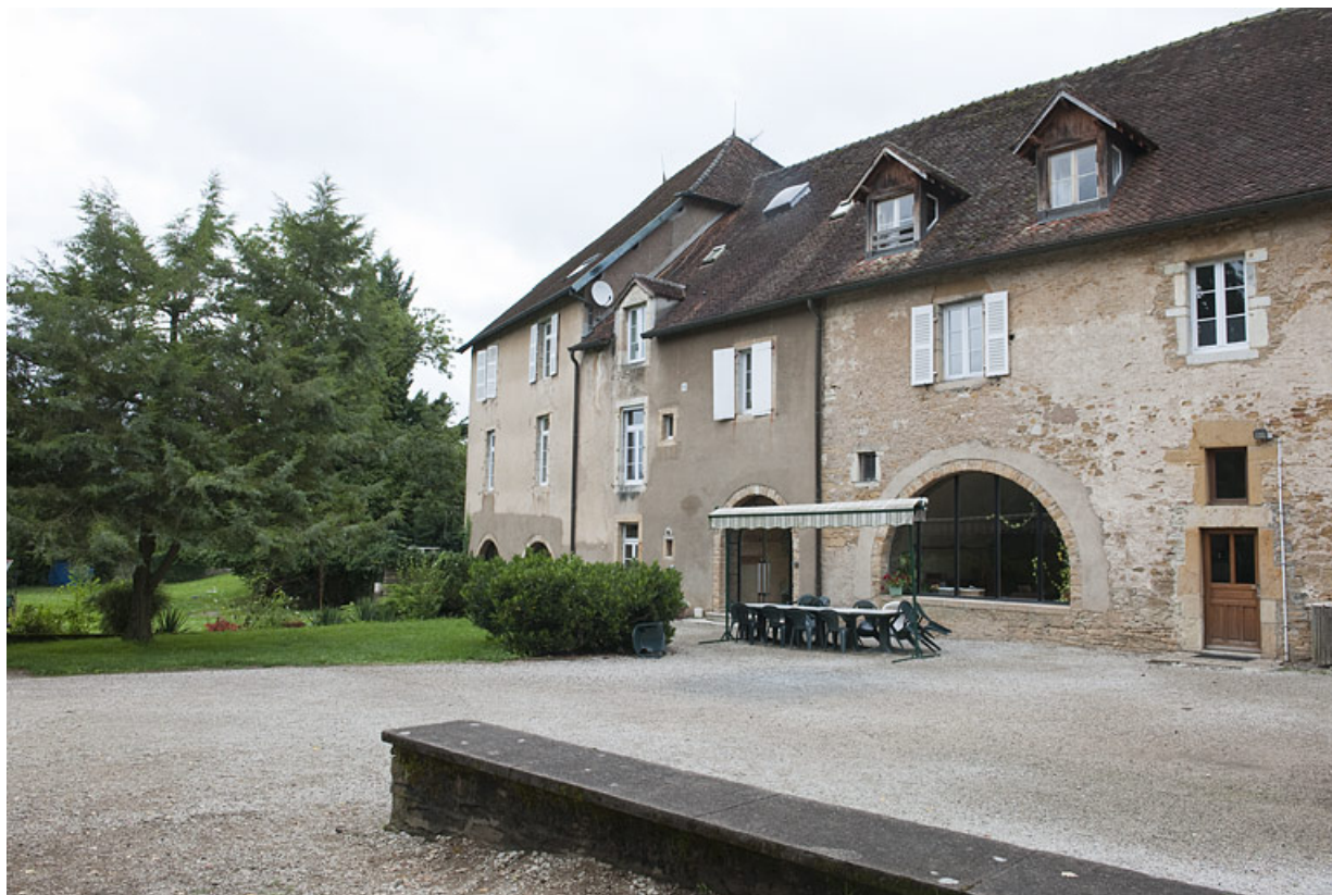
Revers des façades du côté de la rue des Fossés (1ère partie).
