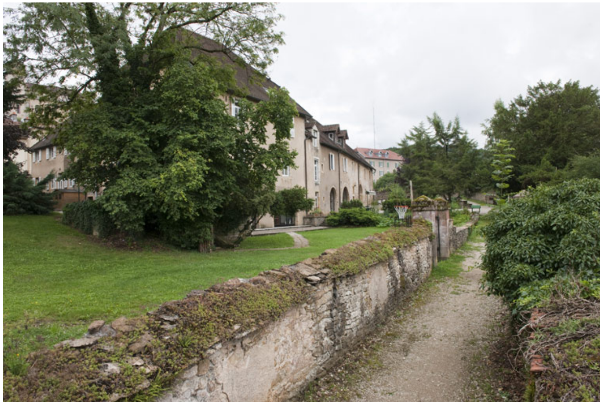
Vue générale des bâtiments depuis la rue des Fossés.
