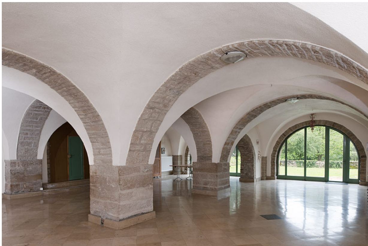
Vue générale des caves voûtées d'arêtes, en direction de la rue des Fossés. 25, Rougemont, 6, 8 rue Basse
