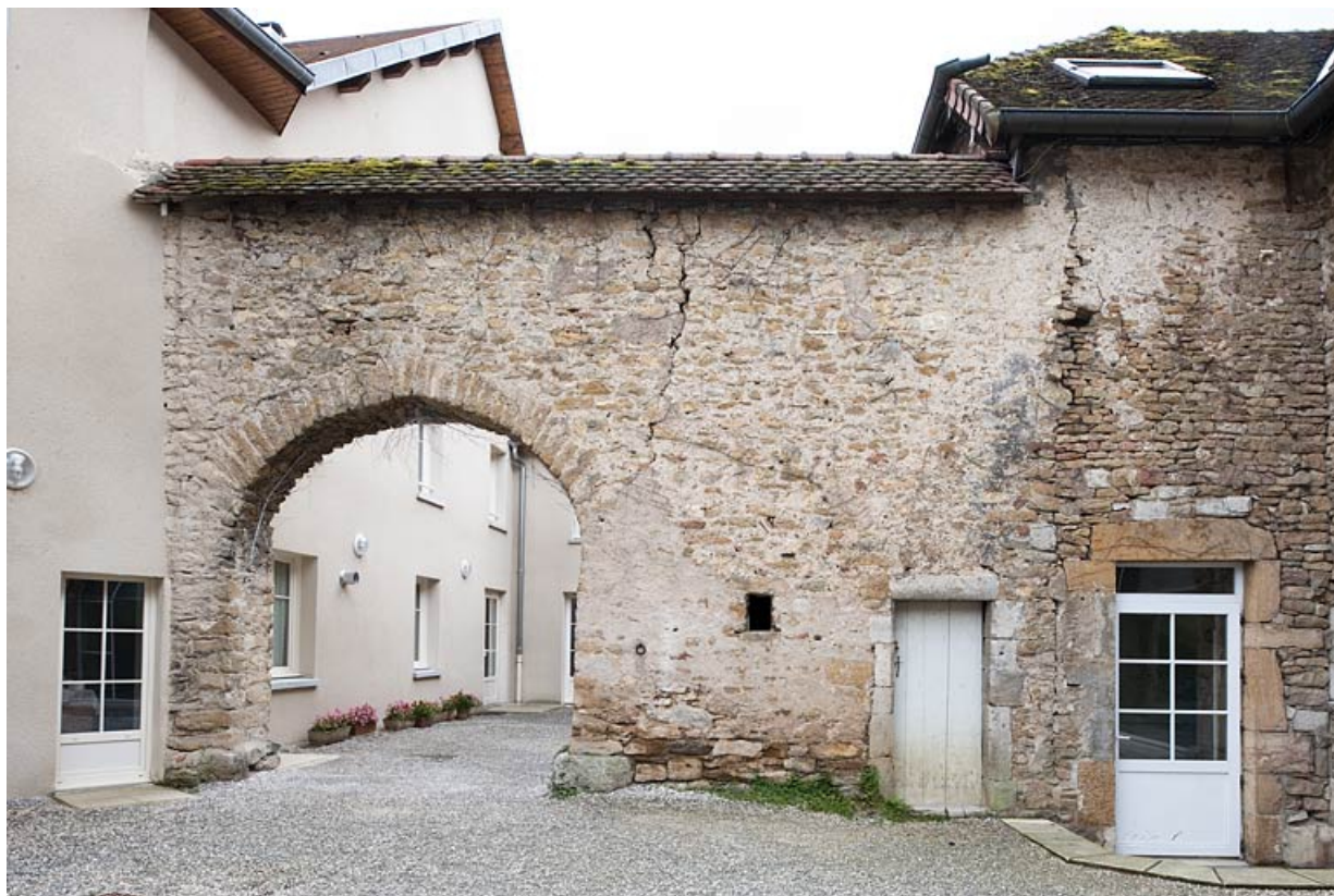
Vestiges de l'ancienne ferme, vue depuis la cour principale.
