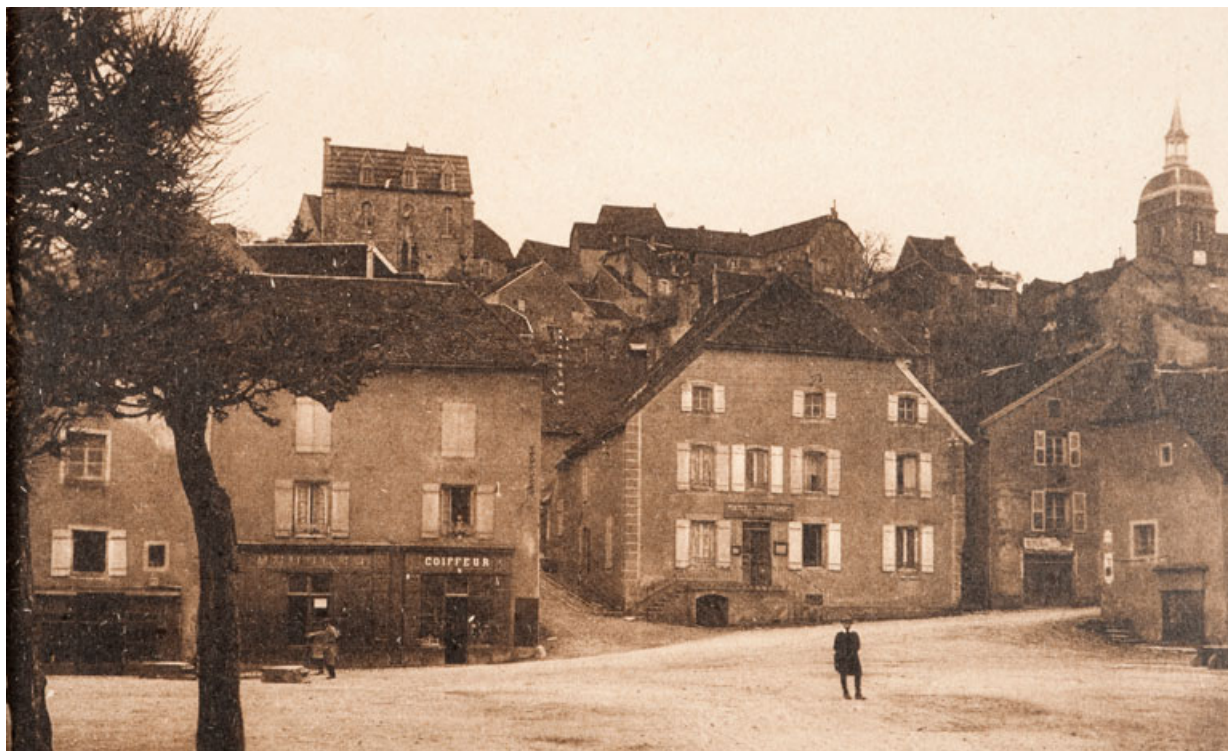
7-ROUGEMONT (Doubs)-Bureau de Poste.
