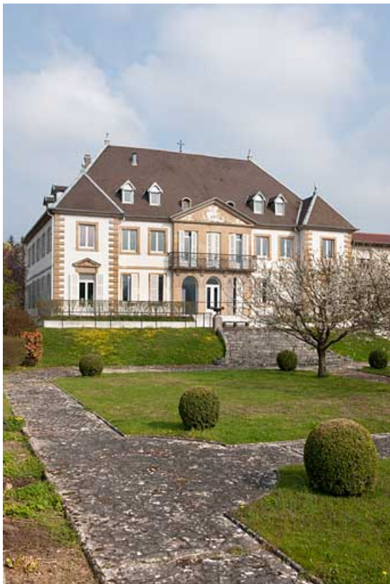
Façade antérieure depuis le jardin.
