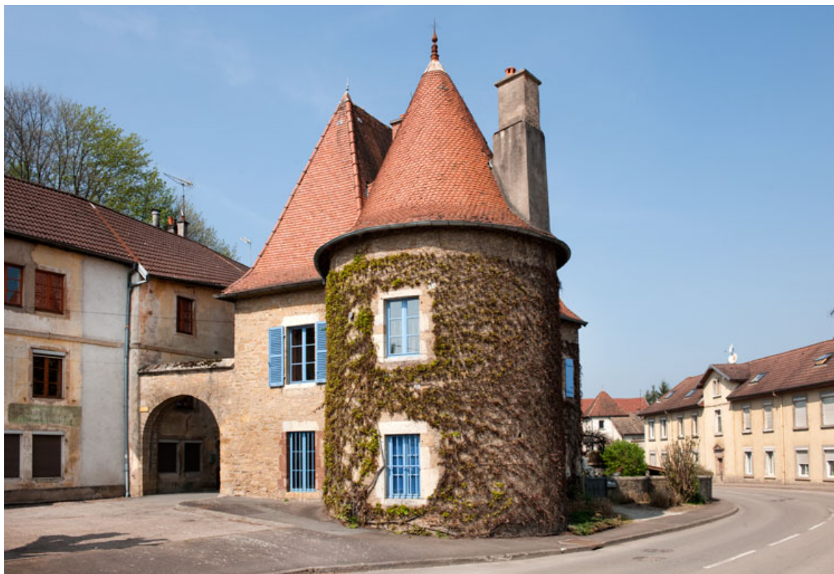
Vue d'ensemble de la porte du Vieux Moulin, de la maison du Vieux Moulin et de l'ancien pavillon d'isolement. 25, Rougemont, 11 rue du Vieux Moulin
