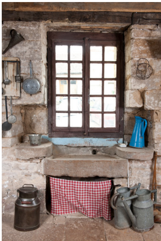
Cuisine : évier en pierre, encastré sous la fenêtre et encadré de niches destinées à la réserve d'eau.
