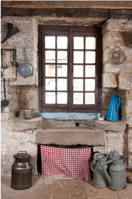
Cuisine : évier en pierre, encastré sous la fenêtre et encadré de niches destinées à la réserve d'eau. 25, Rougemont, 4 quartier de la Citadelle
