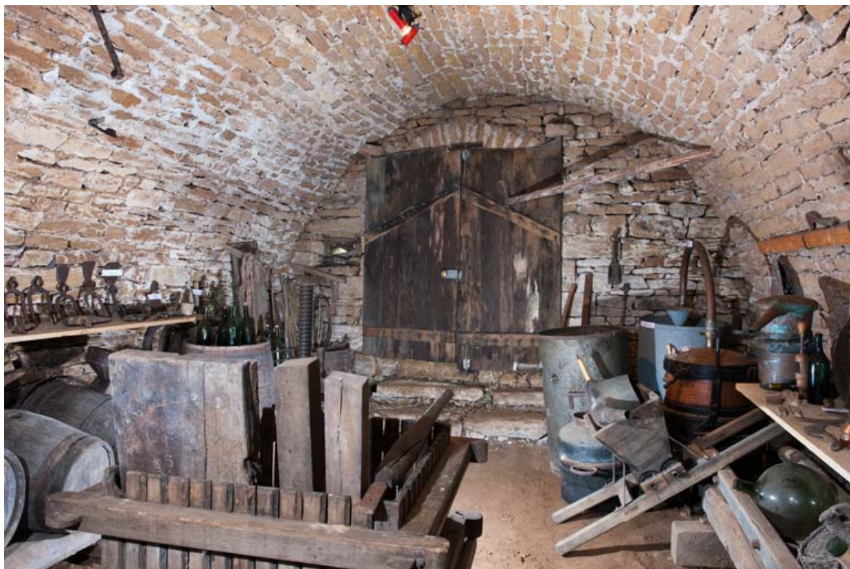
Vue générale de la cave depuis l'entrée.
