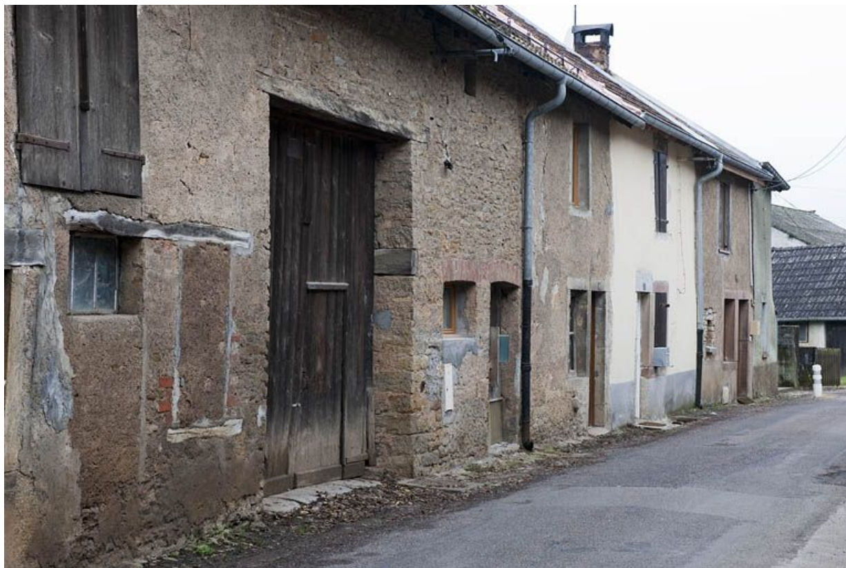
Vue d'ensemble des maisons du côté pair de la rue des Juifs.
