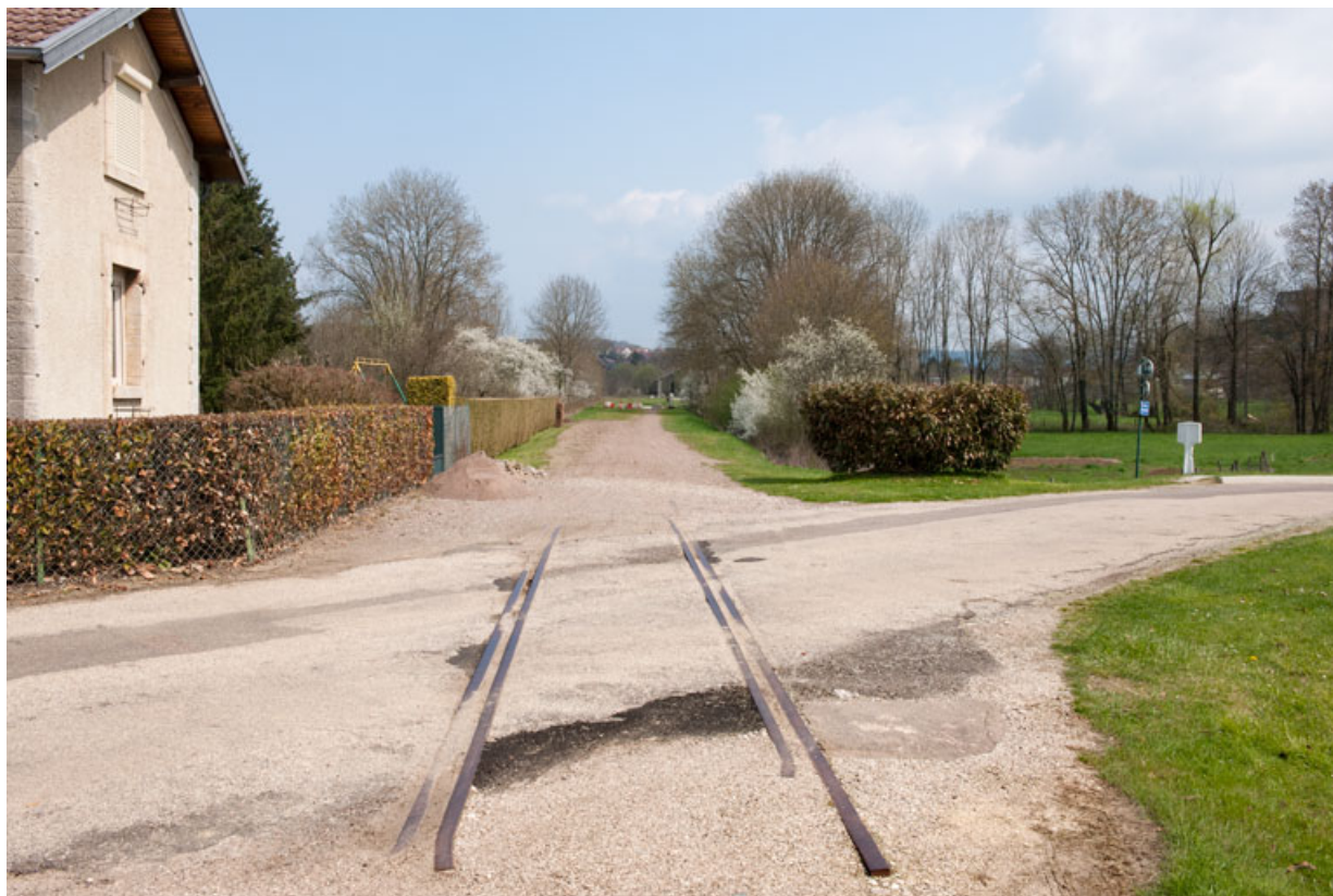
Tracé de la voie au niveau de la maison de garde-barrière, chemin du Souvenir français. Noter les rails encore en place. 25, Rougemont avenue de la Gare
