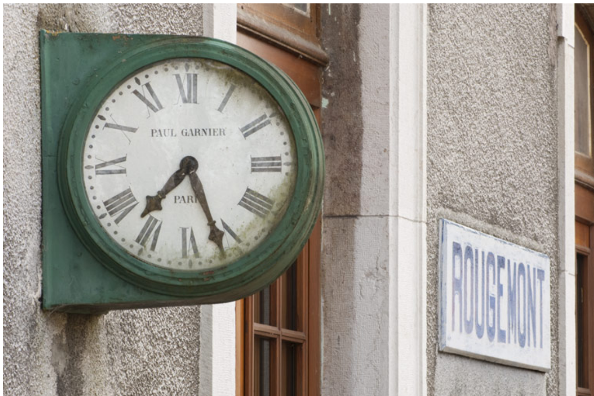
Bâtiment des voyageurs : horloge Paul Garnier. 25, Rougemont avenue de la Gare
