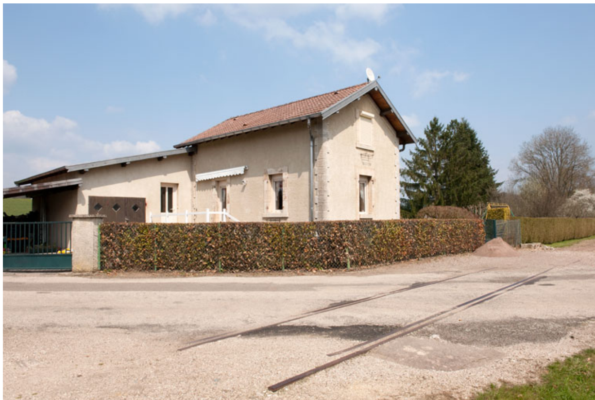
Maison de garde-barrière, chemin du Souvenir français : vue rapprochée. Noter les rails encore en place. 25, Rougemont avenue de la Gare
