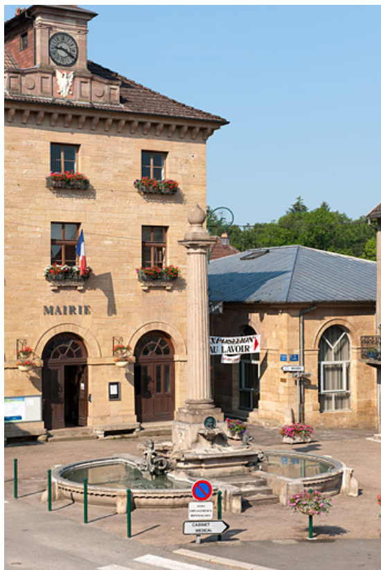
Vue générale ; au second plan la mairie et la halle. 25, Rougemont place du Marché
