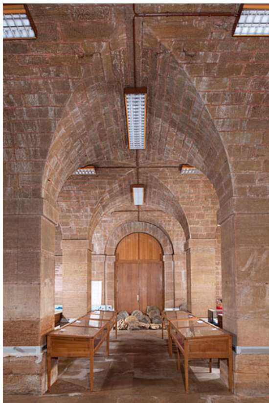
Intérieur : vue en direction de la porte ouvrant sur le hall. 25, Rougemont place du Marché
