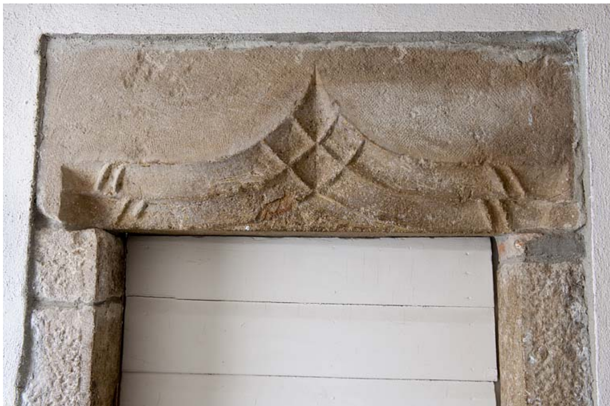
Intérieur : détail du linteau de la baie conduisant à l'ancienne grange.
