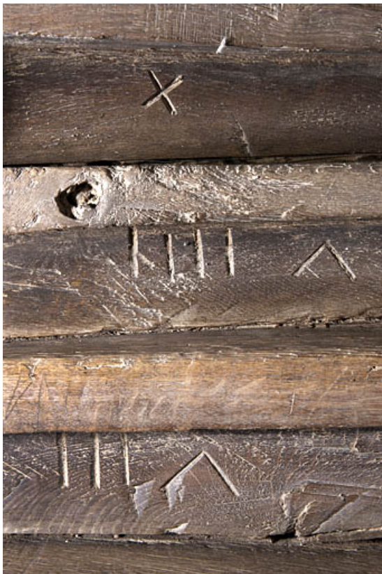
Intérieur : escalier en charpente meant à l'étage, détail des marches numérotées. 25, Rougemont, 2 quartier de la Citadelle
