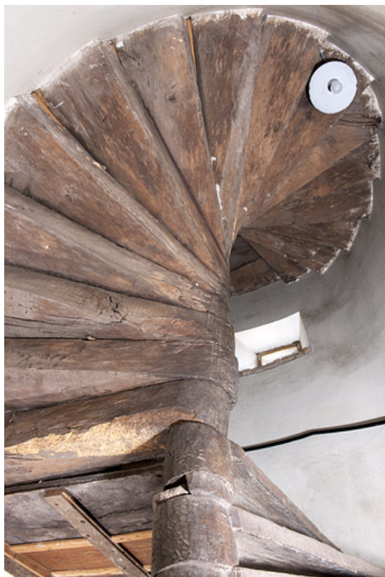
Intérieur : le dessous de l'escalier en vis menant à l'étage.
