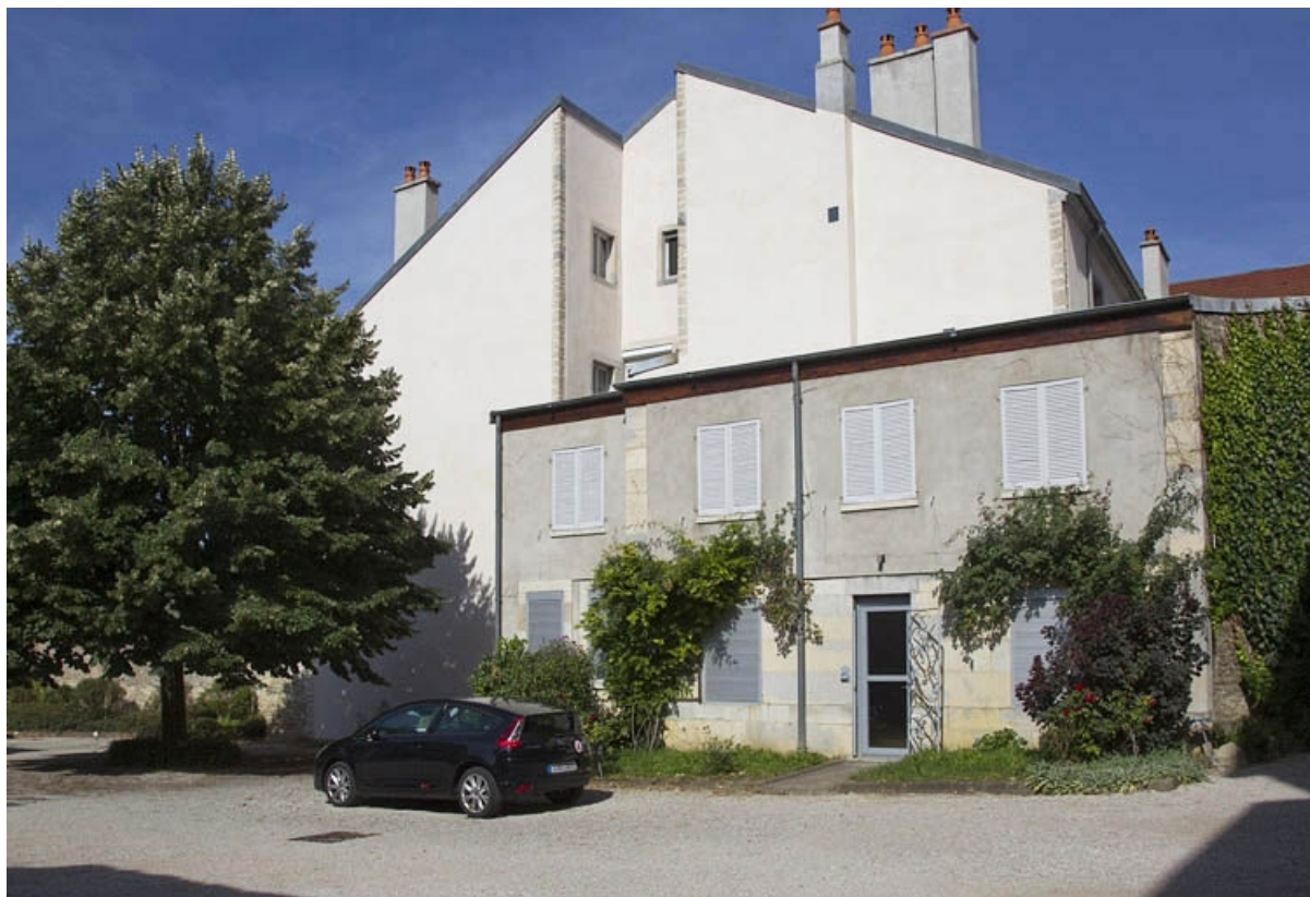
Bâtiment des anciennes écuries : vue d'ensemble, de trois quarts droit.
