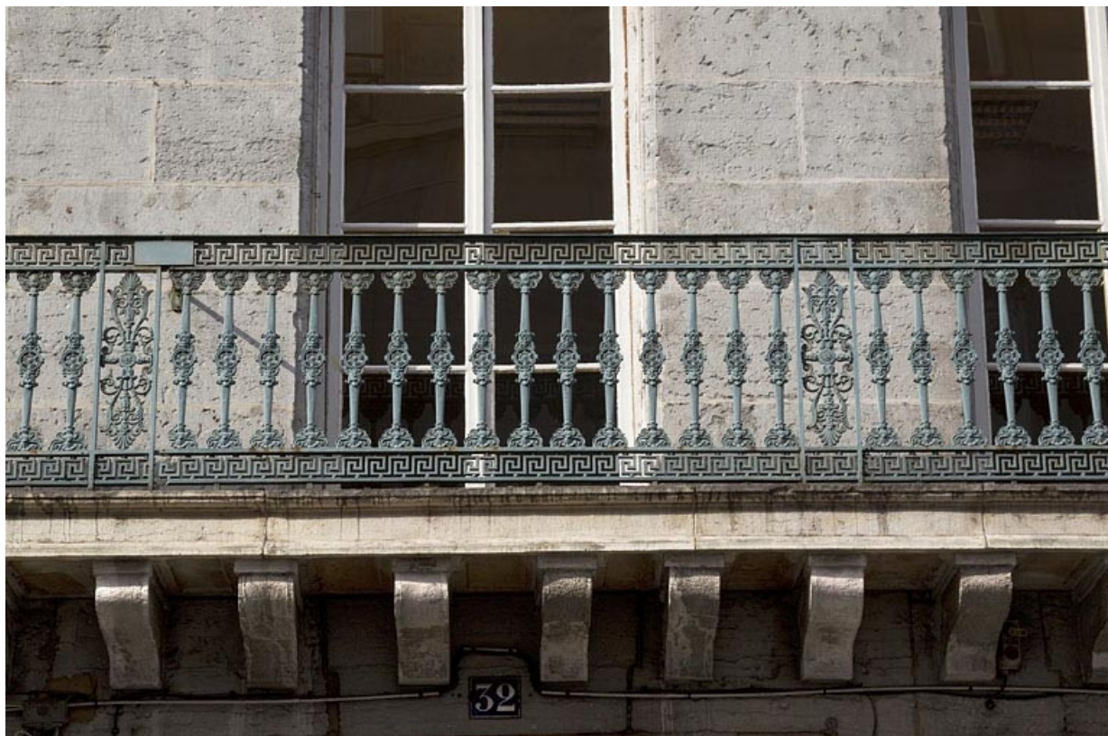
Façade antérieure, premier étage, balcon filant : détail du garde-corps.
