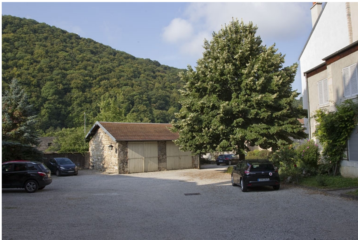
Cour : bâtiment des anciennes remises, de trois quarts gauche.
