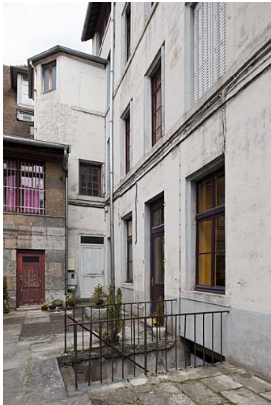
Détail de la façade postérieure de l'immeuble, partie gauche.
