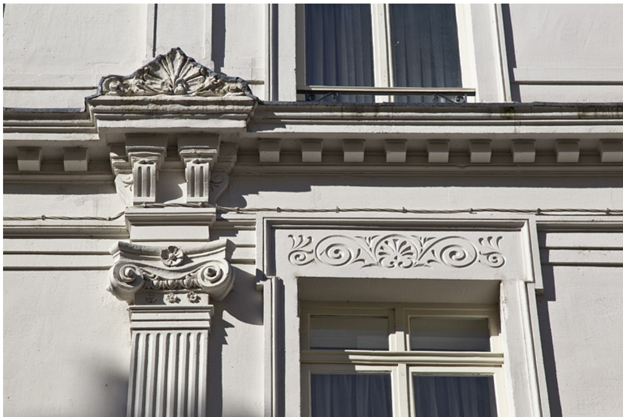
Façade antérieure : détail d'un chapiteau ionique et de son couronnement.
