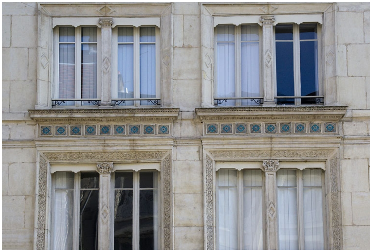
Façade antérieure : détail du décor des fenêtres des premier et deuxième étages : de face.
