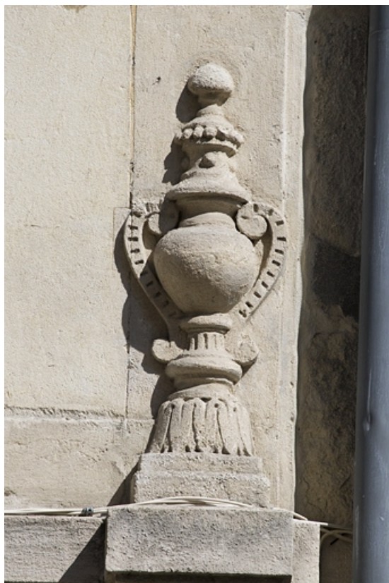
Façade antérieure : détail du décor en urne cantonnant la façade au-dessus du premier étage. 25, Besançon, 14 rue Proudhon, lieudit : îlot Saint-Amour
