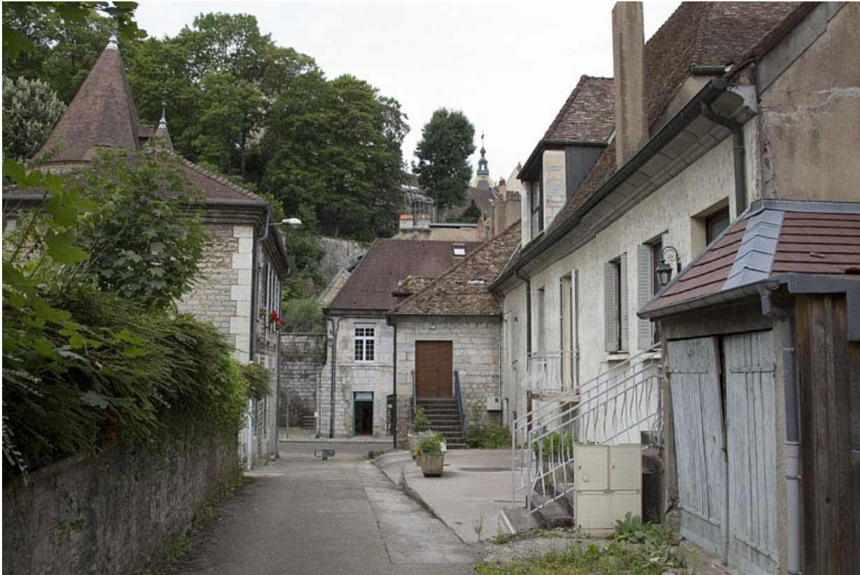
Façade latérale droite depuis le fond de la venelle. 25, Besançon, 19 rue Rivotte, lieudit : îlot Porte Rivotte
