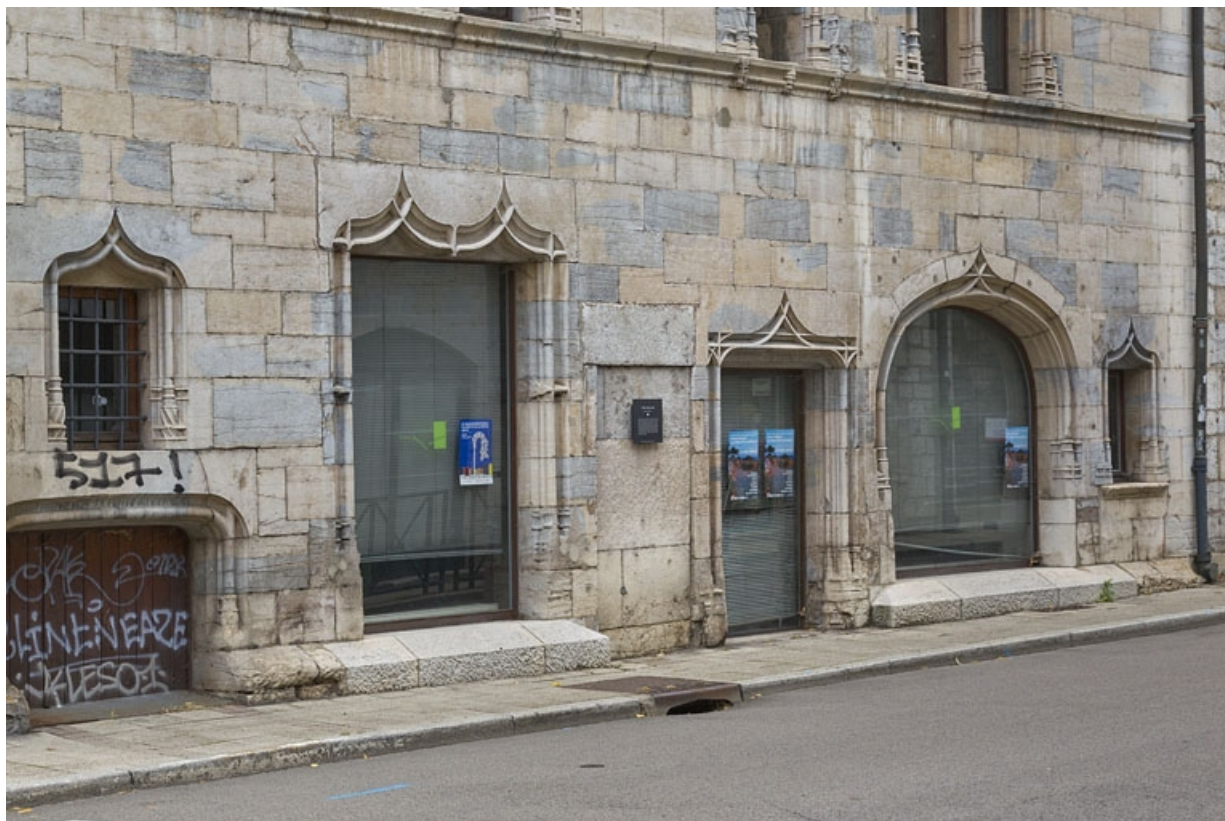
Façade rue Rivotte, détail du rez-de-chaussée, de trois quarts gauche.
