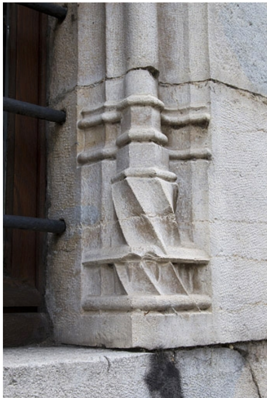
Façade antérieure, fenêtre au-dessus de l'entrée de cave : détail de la base prismatique droite. 25, Besançon, 19 rue Rivotte, lieudit : îlot Porte Rivotte
