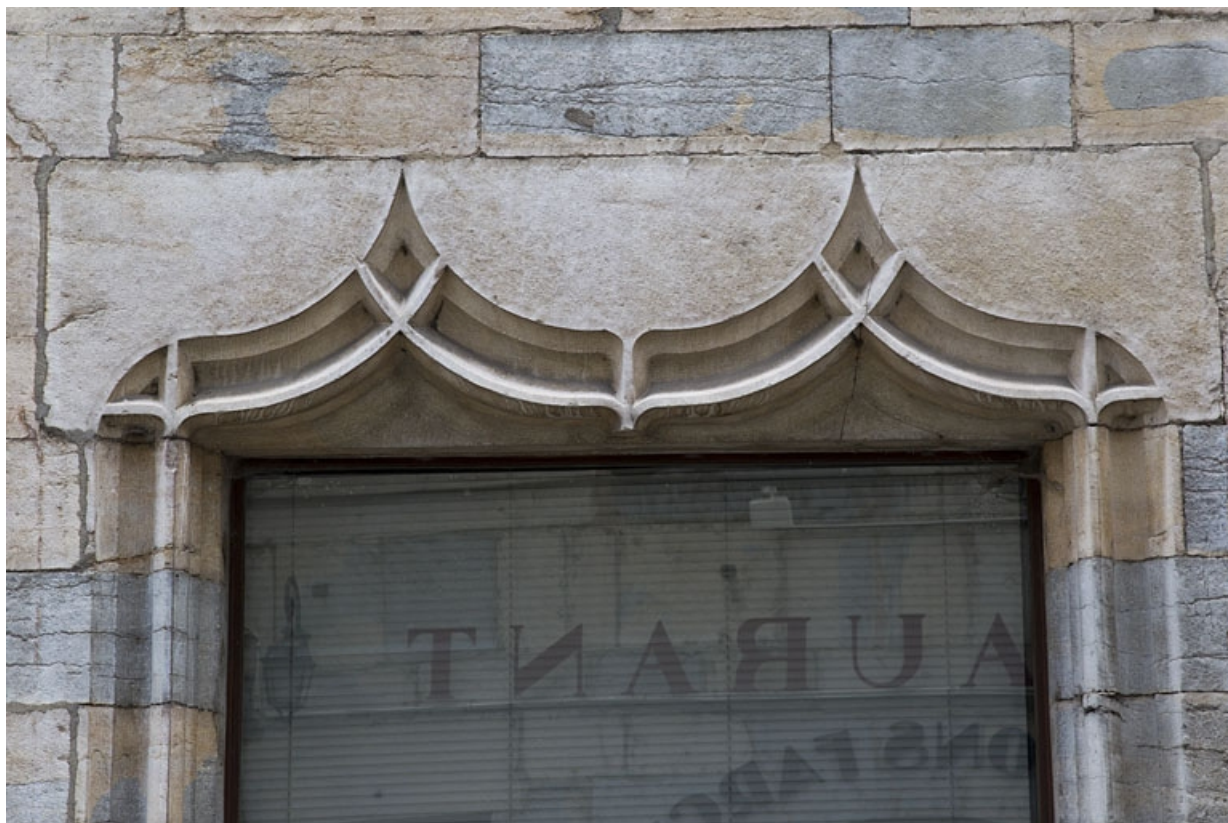
Façade antérieure : détail de l'arc en accolade de la baie à gauche l'ancienne entrée.
