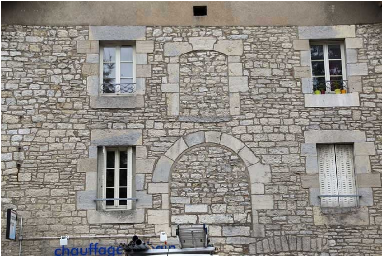
Bâtiment des remises et écuries : détail de la façade antérieure.
