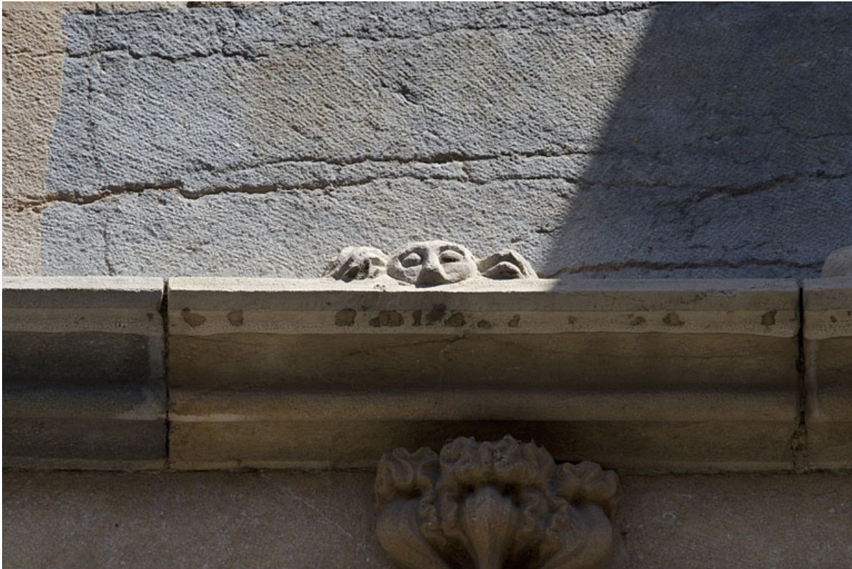
Façade antérieure, premier étage, baie centrale : détail de la partie centrale de l'archivolte.
