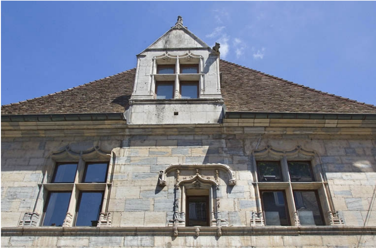
Façade antérieure, premier étage et lucarne : vue d'ensemble, de face.
