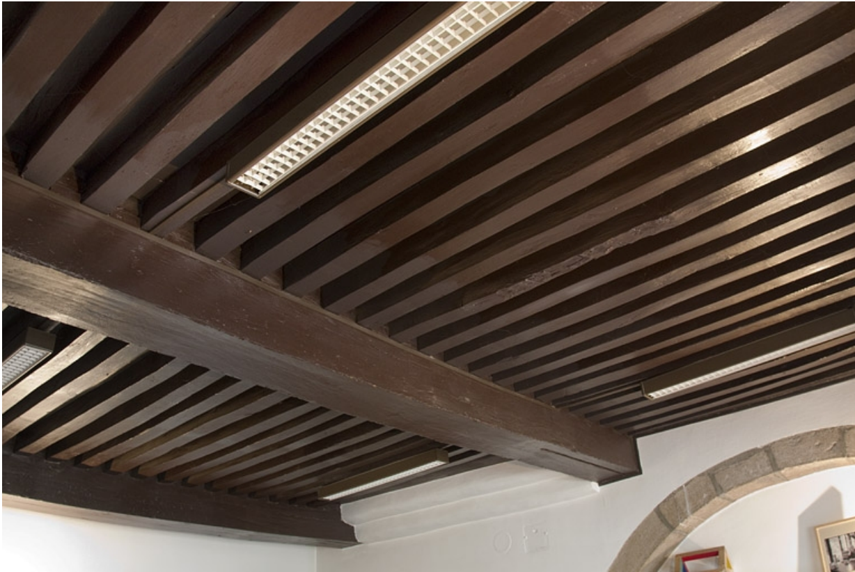
Intérieur, rez-de-chaussée : détail d'un plafond à la française.
