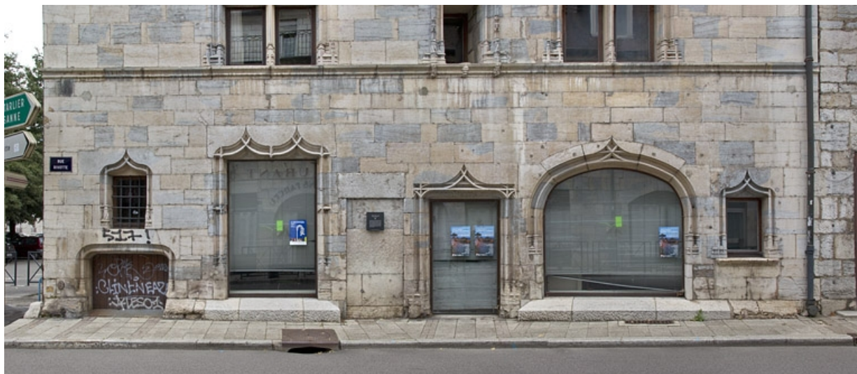
Façade rue Rivotte, détail du rez-de-chaussée, de face.
