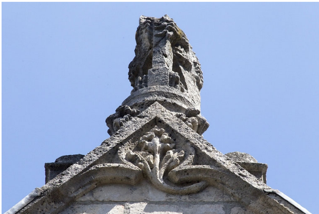
Façade antérieure, lucarne : détail de la sculpture ornant la pignon, de face.
