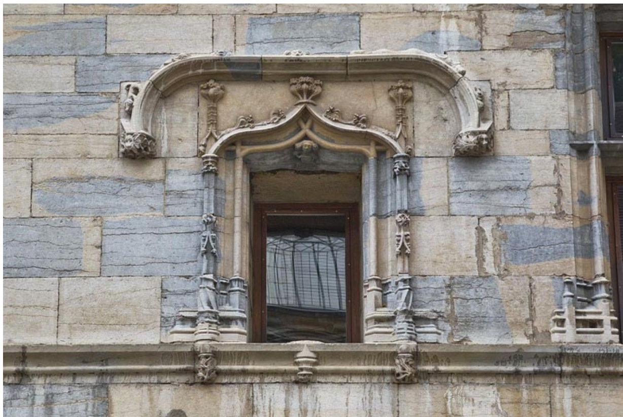
Façade antérieure, premier étage : détail de la fenêtre centrale, de face.
