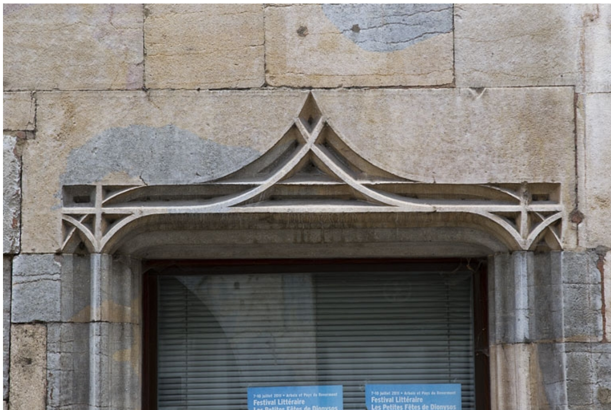
Façade antérieure : détail de l'arc en accolade de l'ancienne entrée.
