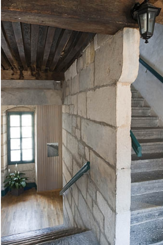
Intérieur : escalier principal en pierre, dernière volée.
