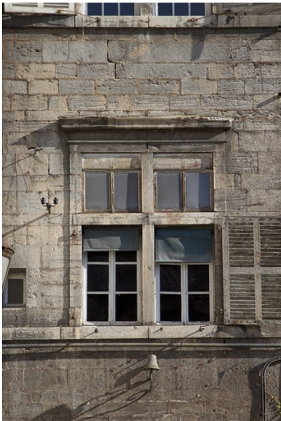
Façade antérieure, tour droite : détail d'une fenêtre du premier étage.
