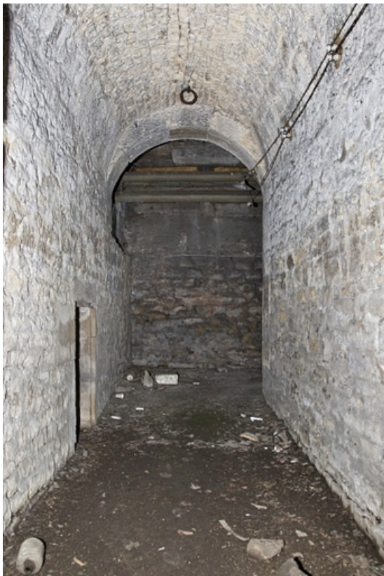
Sous-sol : détail d'un couloir voûté en berceau.
