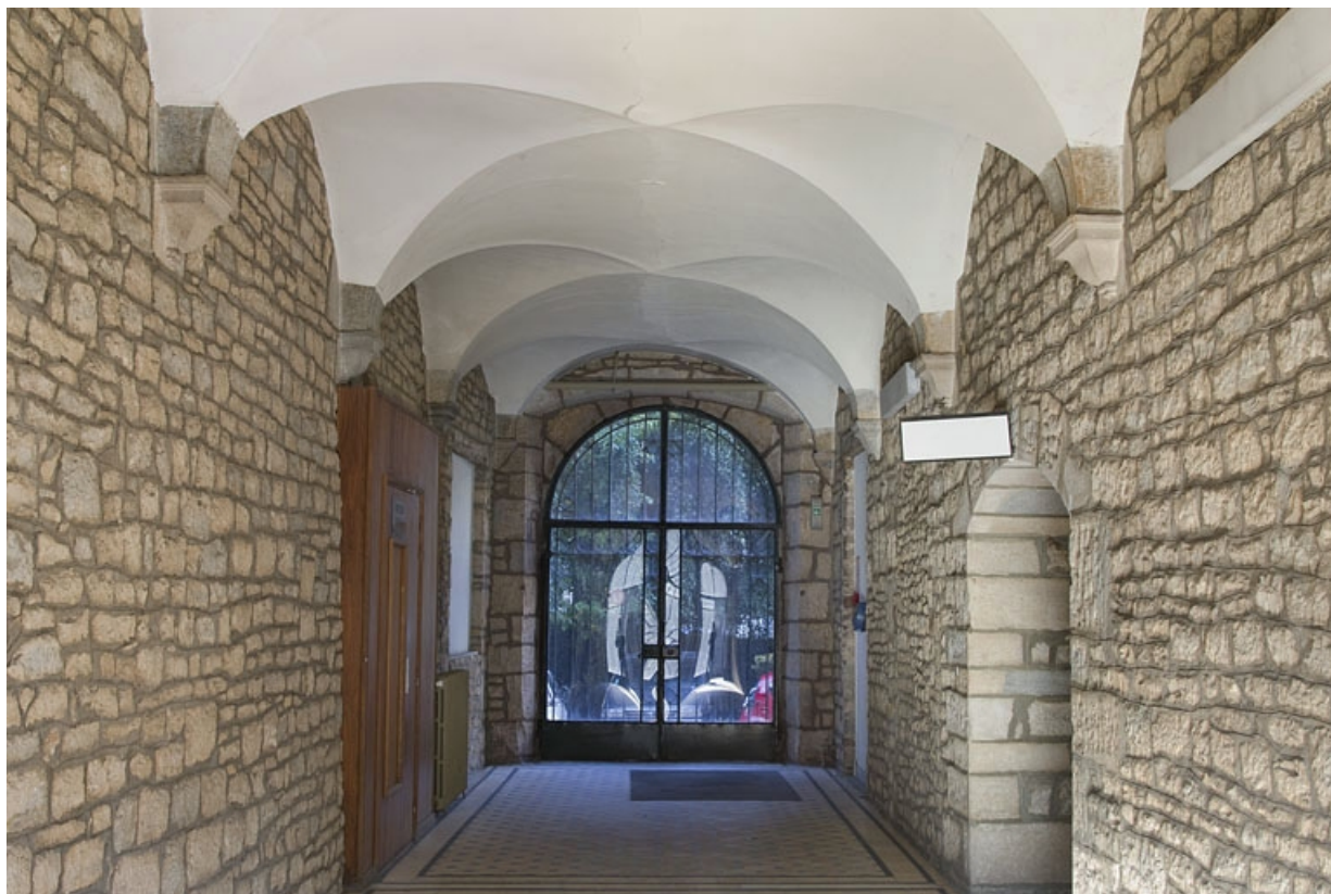
Intérieur : vue d'ensemble du couloir depuis l'entrée.
