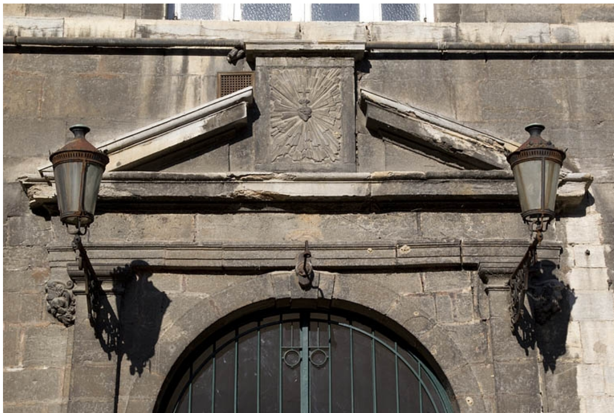
Façade antérieure, portail d'entrée : détail du fronton.
