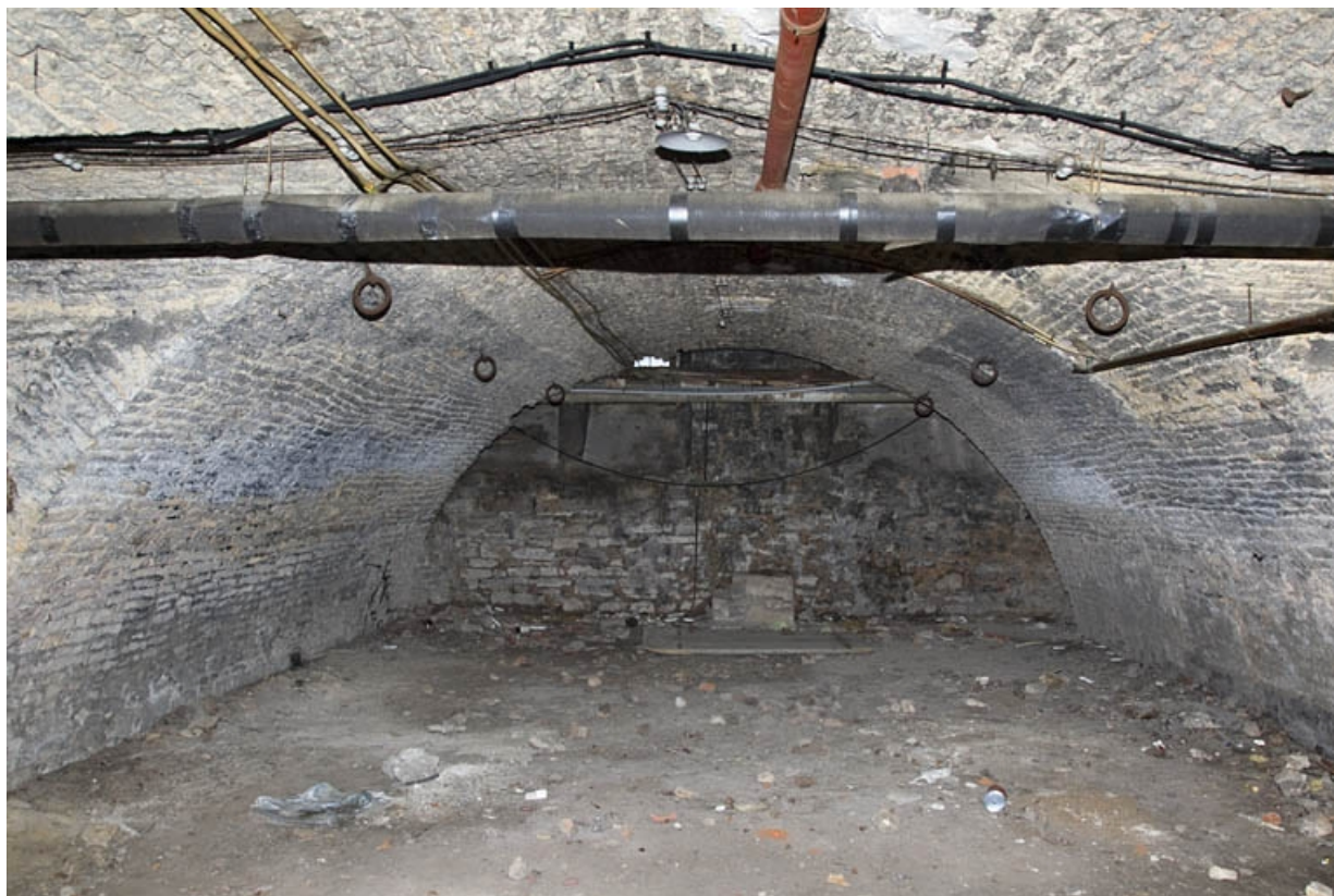
Sous-sol : détail d'une cave voûtée en berceau.
