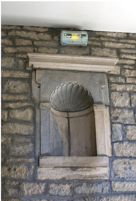
Intérieur : détail d'une niche à coquille décorant la cage de l'escalier. 25, Besançon, 12 rue de l' Orme de Chamars, lieudit : îlot Saint-Jacques
