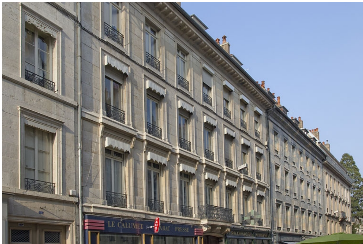
Logis principal : vue d'ensemble depuis la rue à partir du premier étage, de trois quarts gauche. 25, Besançon, 7 rue Morand, lieudit : îlot Morand
