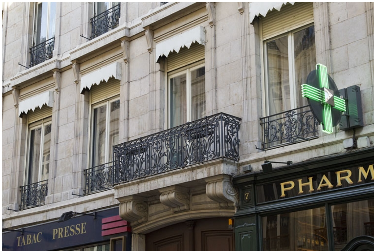
Logis principal, façade antérieure : détail des garde-corps et du balcon du premier étage.
