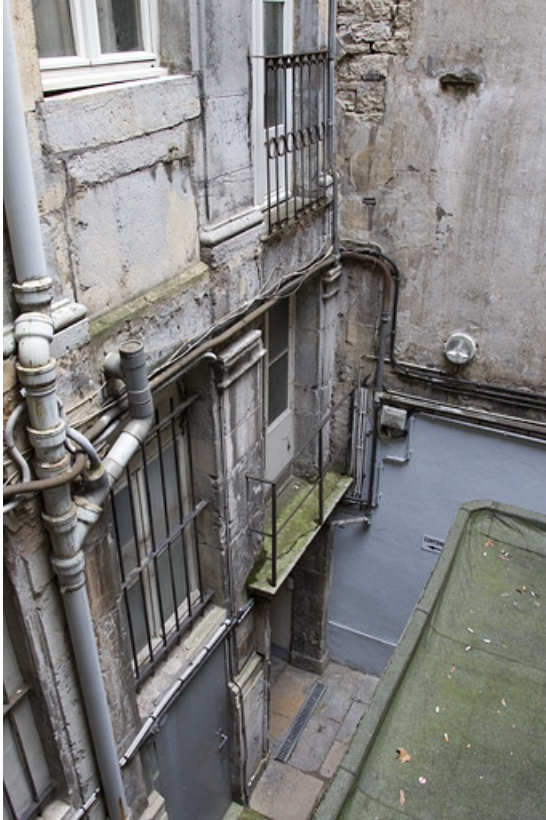
Logis secondaire : détail d'une partie de la façade à partir du rez-de-chaussée sur la première cour. 25, Besançon, 49 rue des Granges, lieudit : îlot Morand
