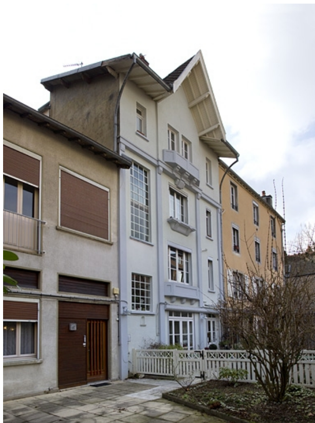
Vue d'ensemble des logis secondaires dans les troisième et quatrième cours, depuis le fond de la parcelle. 25, Besançon, 35 rue des Granges, lieudit : îlot Morand
