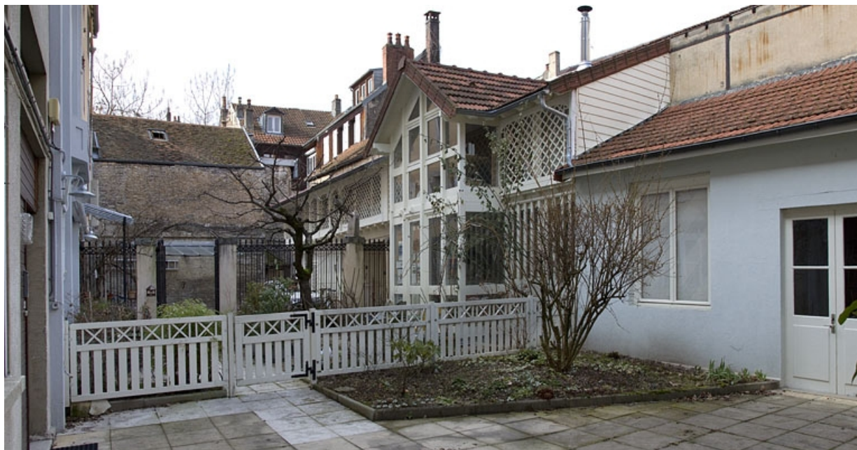
Vue d'ensemble de l'ancien atelier depuis la quatrième cour, de trois quarts droit.
