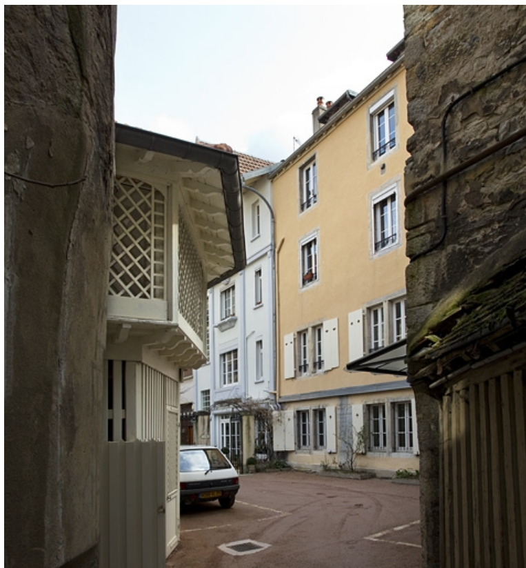
Vue d'ensemble du logis secondaire dans la troisième cour, de trois quarts droit. 25, Besançon, 35 rue des Granges, lieudit : îlot Morand
