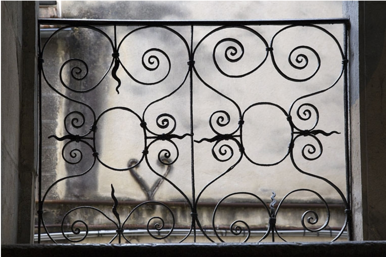
Logis principal : détail d'un garde-corps en ferronnerie de l'escalier à cage ouverte.
