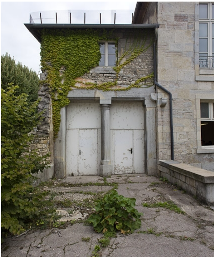
Détail de l'édicule à gauche de la façade donnant sur l'ancien jardin, de face. 25, Besançon, 9 rue Girod de Chantrans, lieudit : îlot Saint-Jacques
