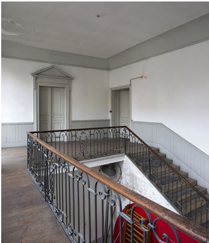
Logis principal, intérieur : vue d'ensemble de l'escalier.
