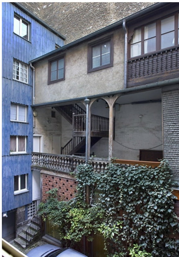
Aile de l'escalier à cage ouverte, de trois quarts droit. 25, Besançon, 6 rue du Lycée, lieudit : îlot Saint-Jacques
