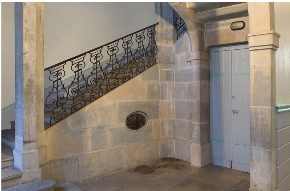
Intérieur, escalier : détail de la rampe en ferronnerie. 25, Besançon, 6 rue du Lycée, lieudit : îlot Saint-Jacques
