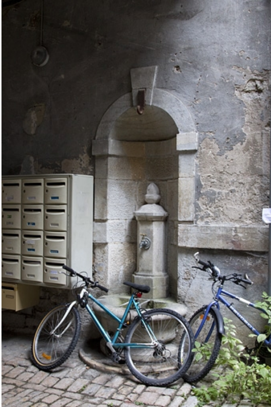
Cour : détail de la borne fontaine.
