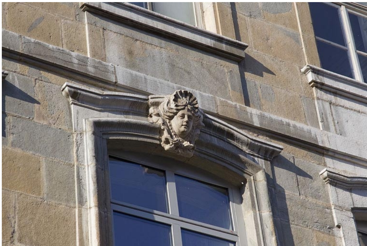
Façade extérieure, rue du lycée, porte-fenêtre du premier étage : détail de la clé décorée d'une tête féminine. 25, Besançon, 6 rue du Lycée, lieudit : îlot Saint-Jacques
