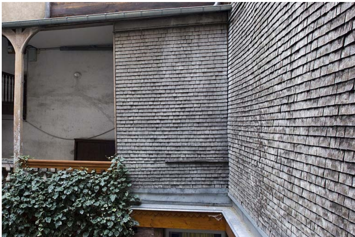
Ailes de l'escalier à cage ouverte et du passage cocher : détail de l'essentage en tavillons.
