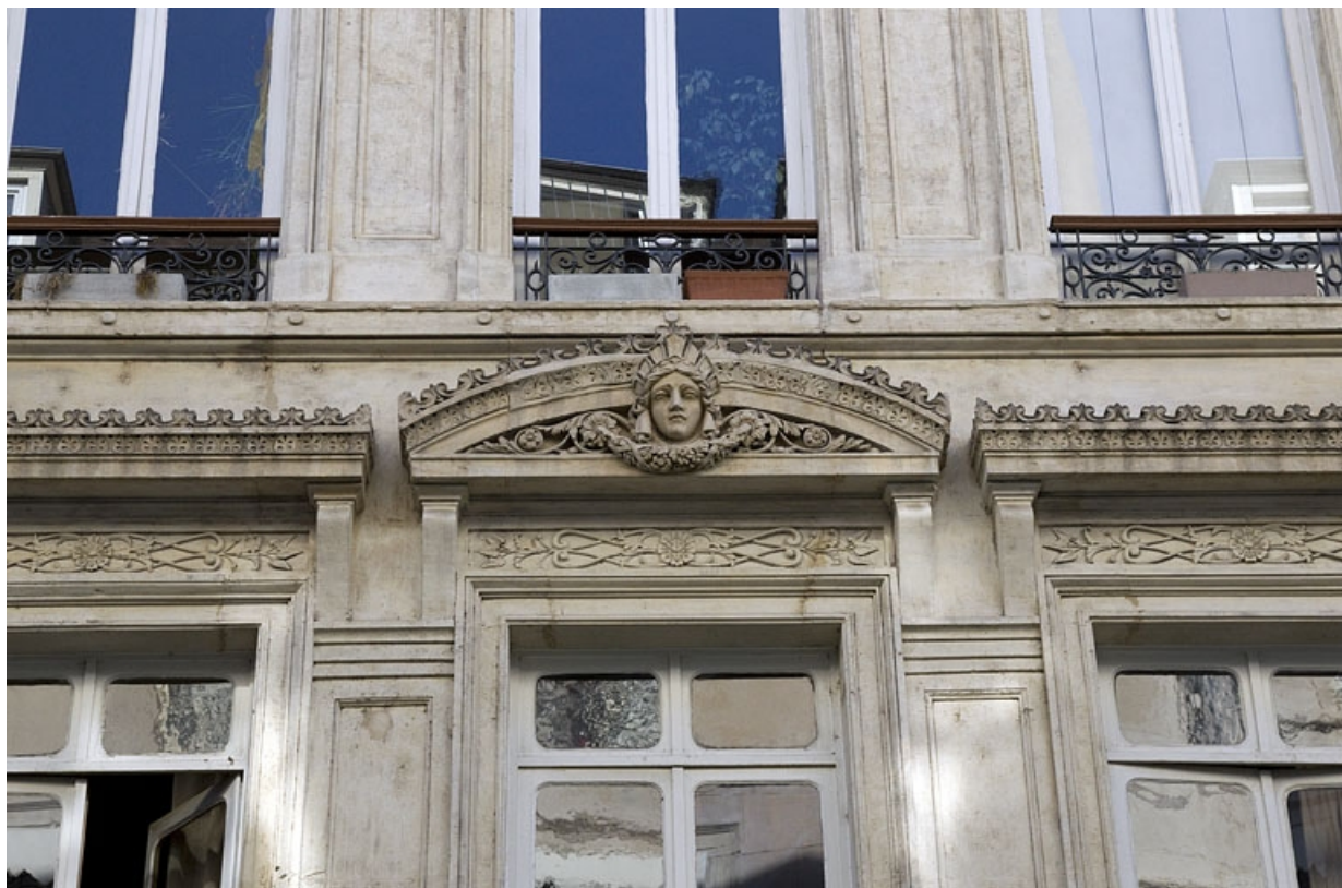
Façade antérieure, premier étage : détail du fronton sur la fenêtre centrale.
