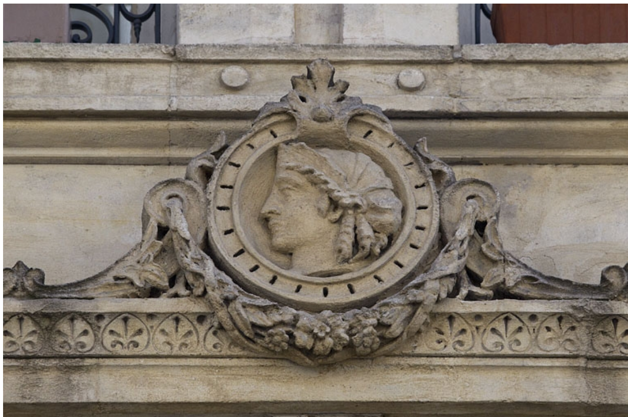
Façade antérieure, premier étage : détail rapproché du décor de la frise droite.
