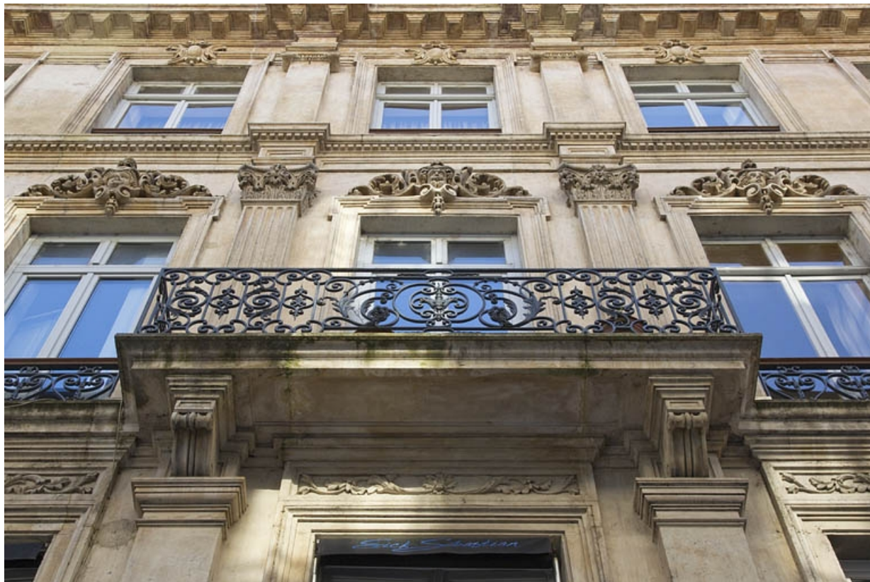
Façade antérieure, rue Morand : vue de la partie centrale en contre plongée.
