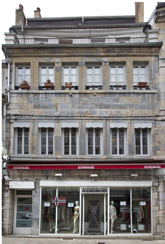
Logis principal, façade antérieure : de face.
