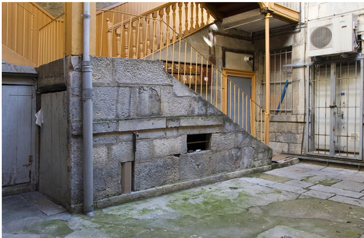
Vue du départ de l'escalier à cage ouverte sur cour.
