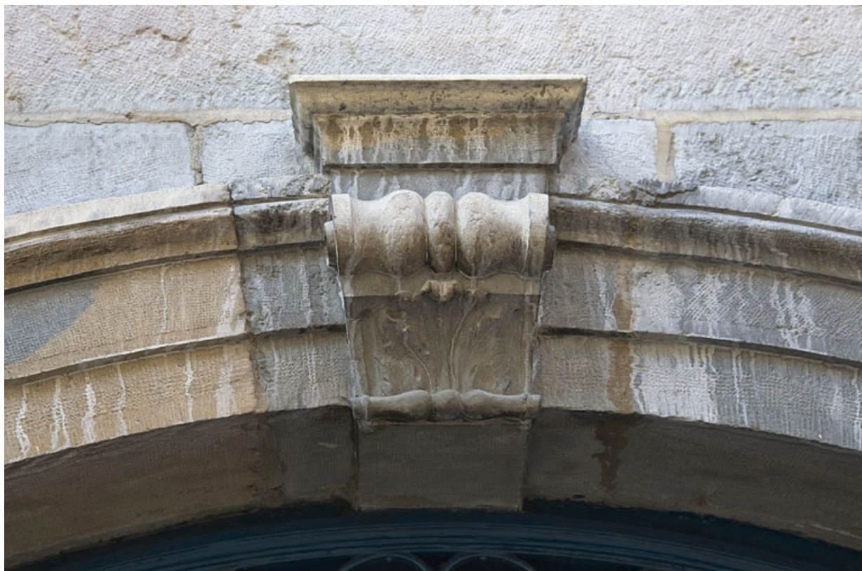
Façade sur rue : détail de la clé de la porte du couloir.
