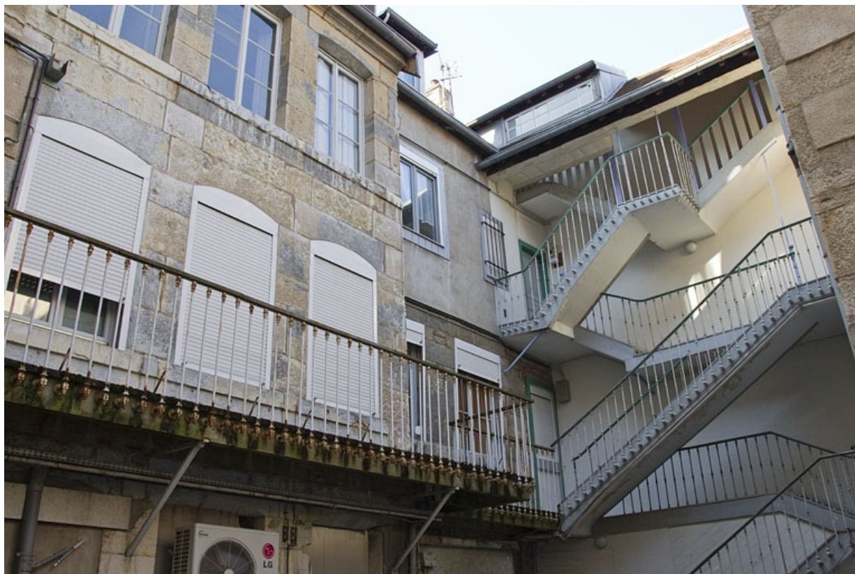
Vue de l'escalier à cage ouverte dans la deuxième cour : partie haute.
