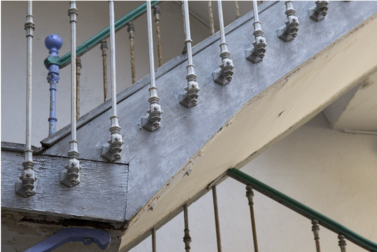
Escalier à cage ouverte dans la deuxième cour : détail de la rampe.
