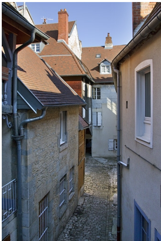
Vue d'ensemble des corps de bâtiment depuis l'entrée de la première cour.
