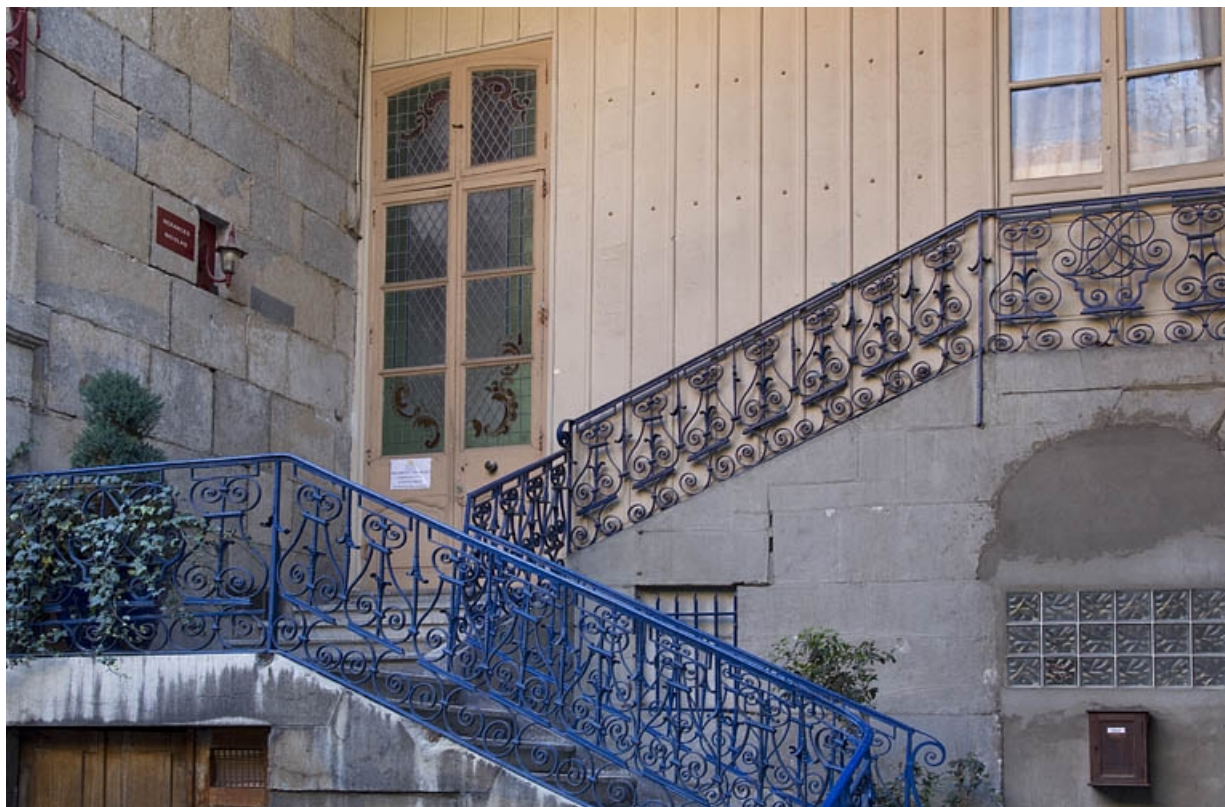
Première cour, aile droite, premier escalier à cage ouverte : détail de la rampe en fer forgé.
