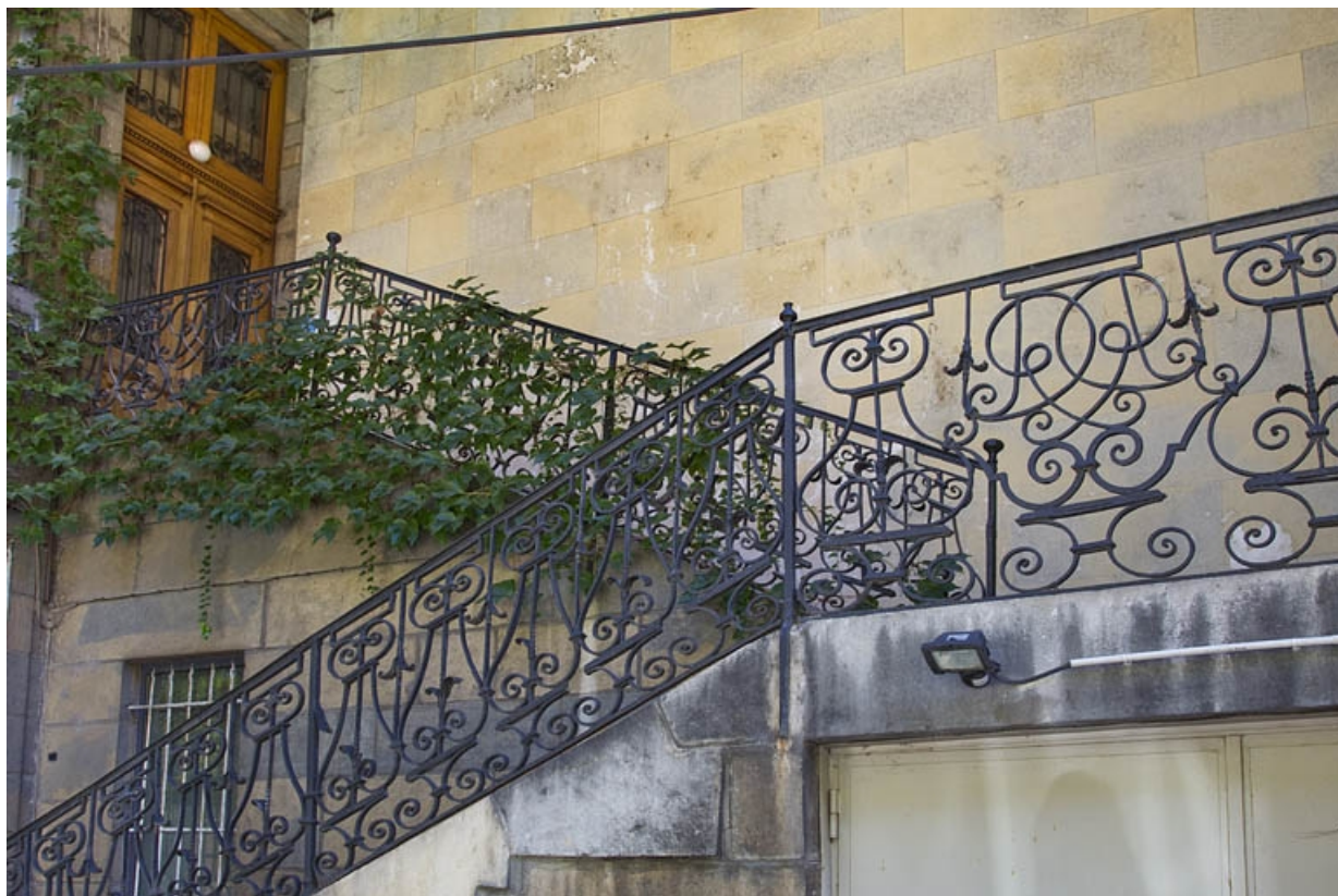
Aile droite, deuxième escalier à cage ouverte : détail de la rampe en fer forgé.
