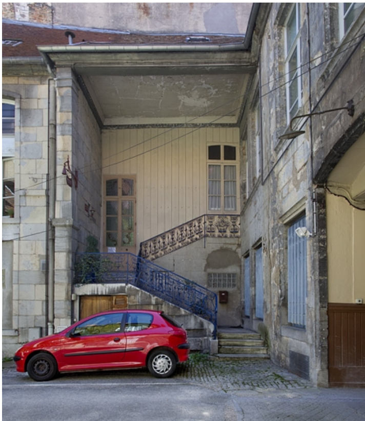
Première cour, aile droite : vue d'ensemble du premier escalier à cage ouverte, de face. 25, Besançon, 23 rue des Granges, lieudit : îlot Poste
