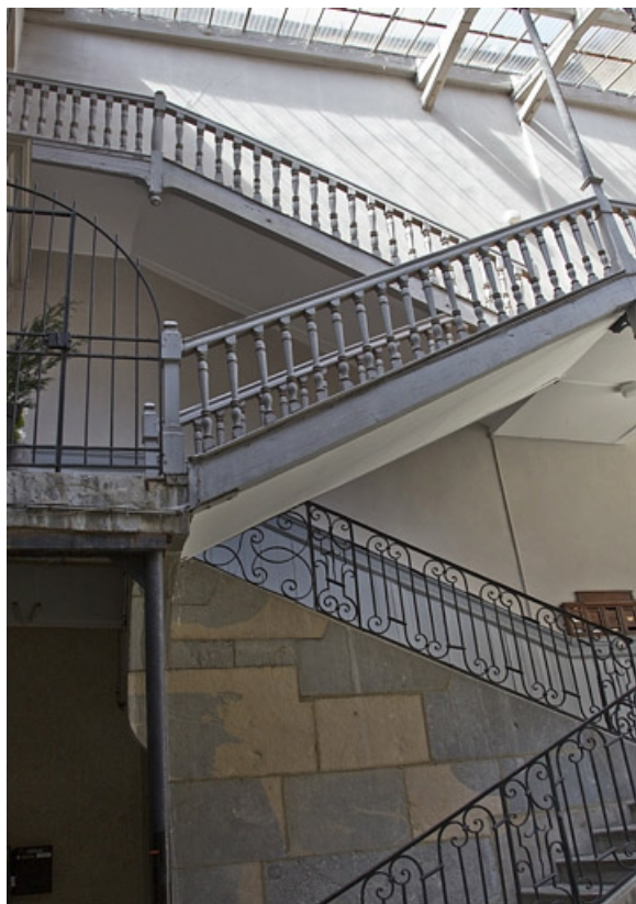
Vue d'ensemble de l'escalier à cage ouverte : de face.
