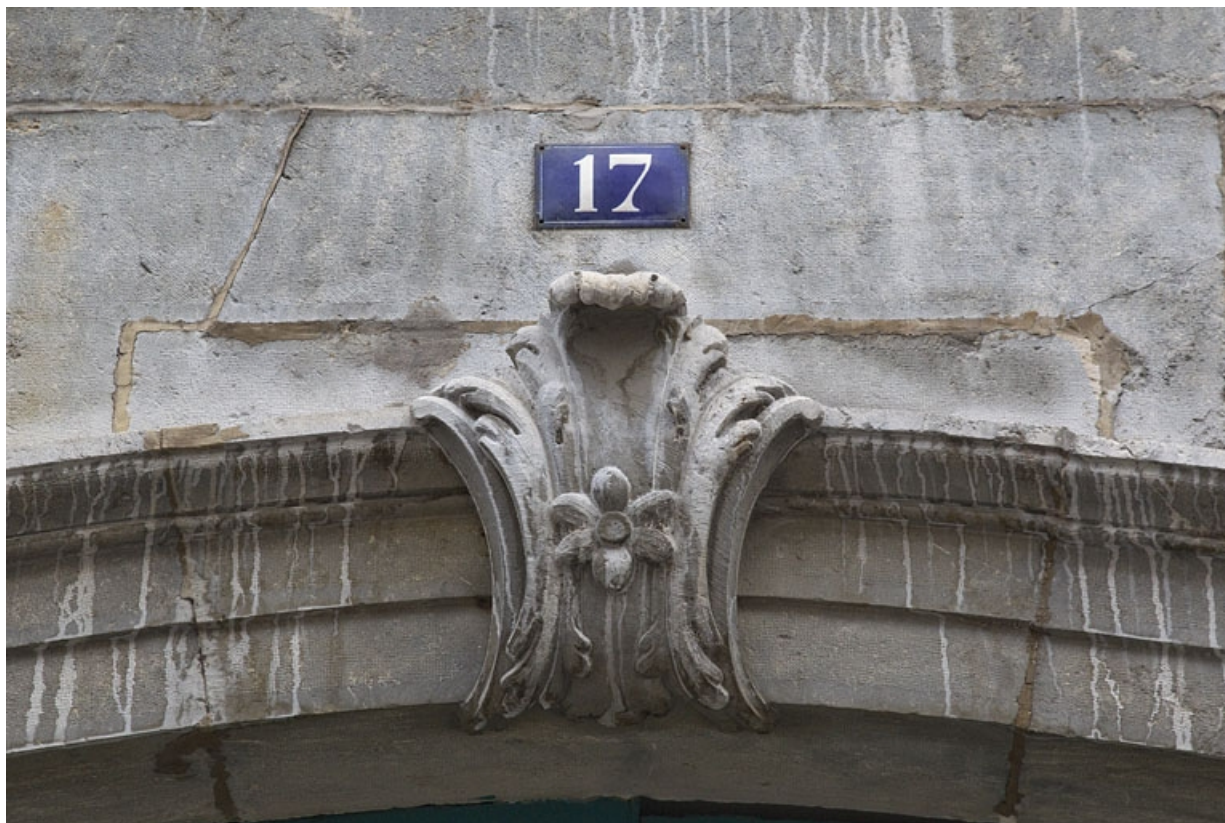
Logis principal, façade antérieure : détail de la clé du portail d'entrée.
